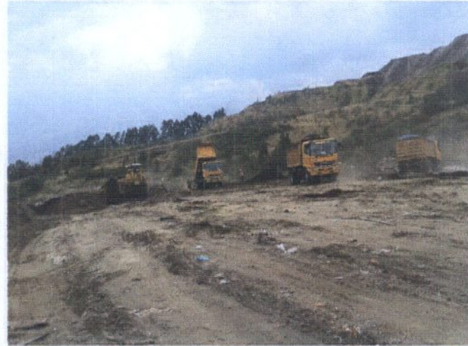
ACOPIO DE MATERIAL PARA CONFORMACION DE RAMPA
