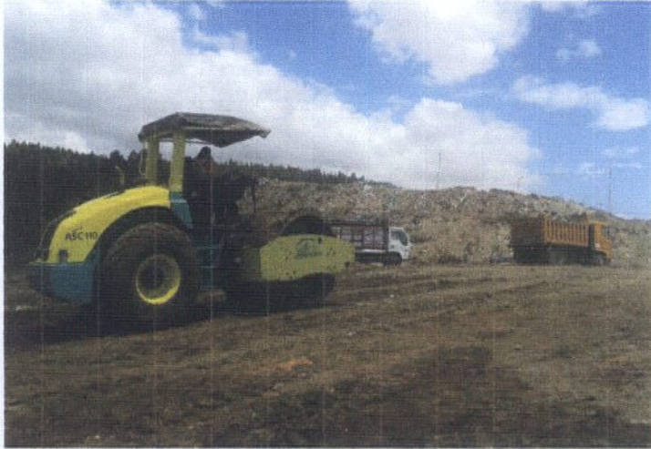
COMPACTACION RAMPA ACCESO PLATAF. 4
