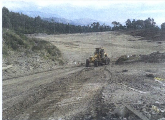
ARREGLO DE VIAS DE ACCESO
