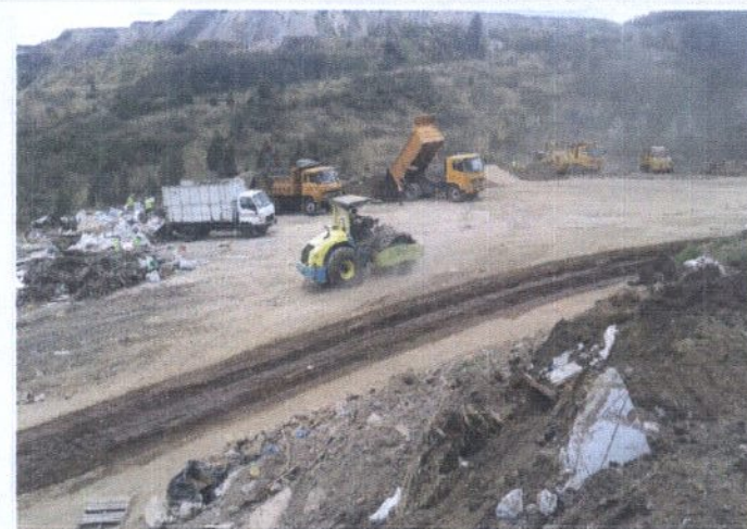
ACOPIO Y COMPACTACION
