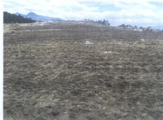
CONFORMACION DE PLATAFORMA AUXILIAR
