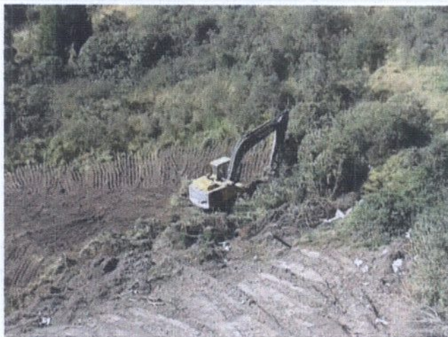
DESBROCE PARA AMPLIACION PLATAF. 4
