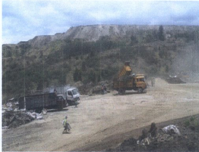
ACOPIO DE MATERIAL PARA AMPLIACION
