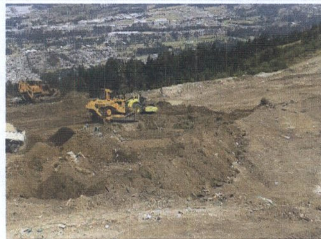
CONFORMACION DE RAMPA ACCESO PLATAF. 4
