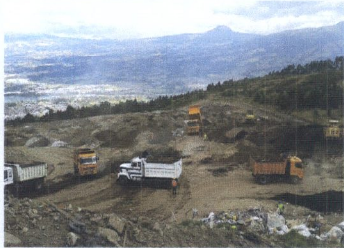
ACOPIO DE MATERIAL PARA UNION PLATAF. 4 Y 5
