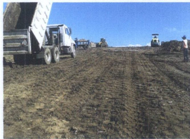
RAMPA DE ACCESO PLATAFORMA 4
