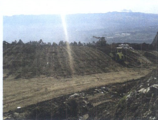
COMPACTACION DE MATERIAL
