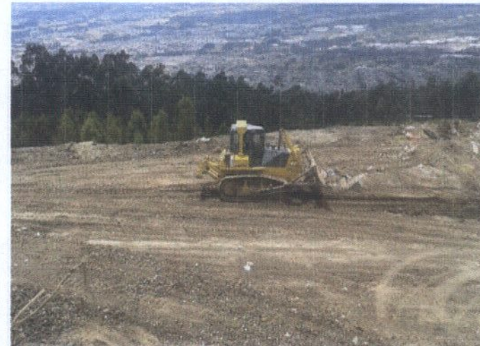
TENDIDO DE MATERIAL PARA AMPLIACION
