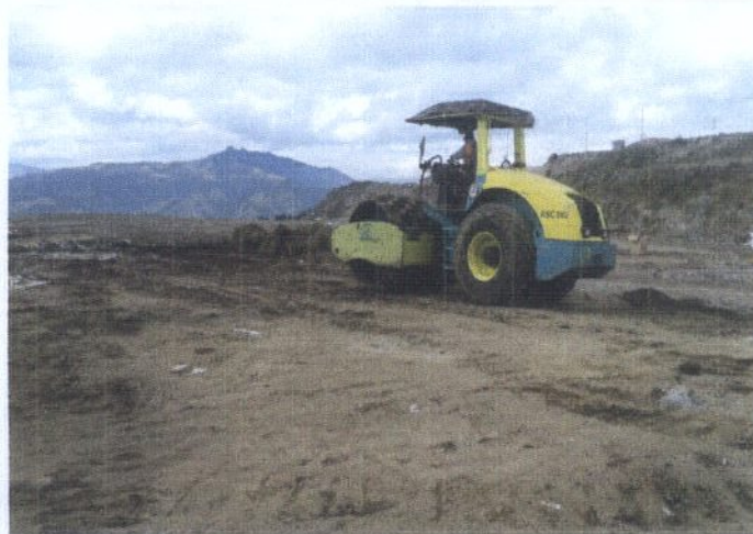
COMPACTACIÓN DE MATERIAL
