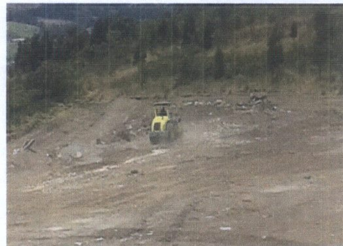
COMPACTACION DE MATERIAL
