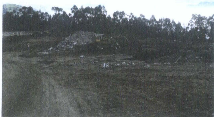
CONFORMACION DE PLATAFORMA
