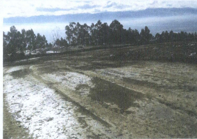
ARREGLO VIA DE ACCESO
