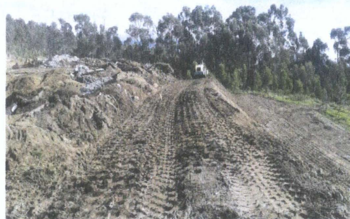
COMPACTACION DE VERMA CON RODILLO
