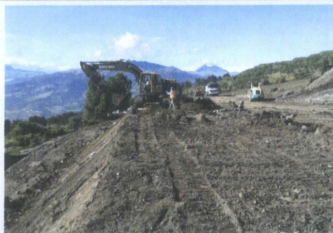
CONFORMACION DE TALUD
