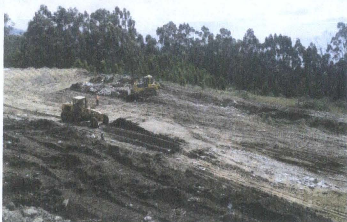
RASANTEO DE PLATAFORMA
