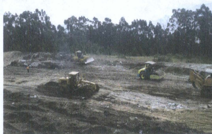
CONFORMACION DE TERRAPLEN
