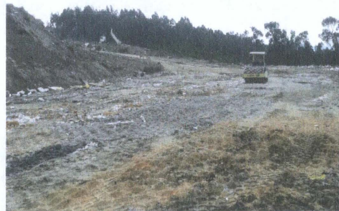
COMPACTACION DE PLATAFORMA CON RODILLO
