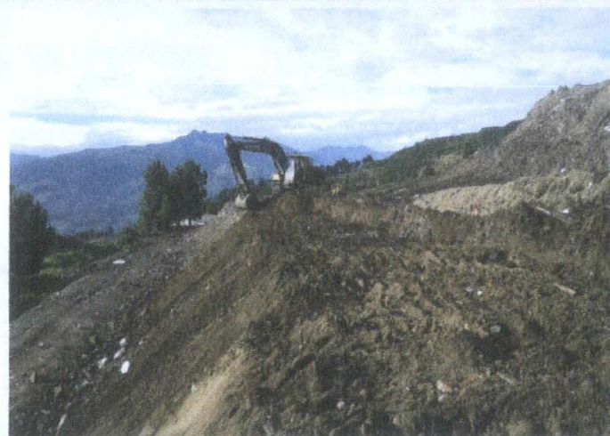
CONFORMACION DE TALUD
