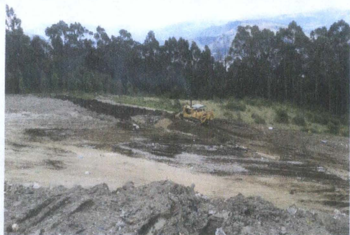
TENDIDO DE ESCOMBROS
