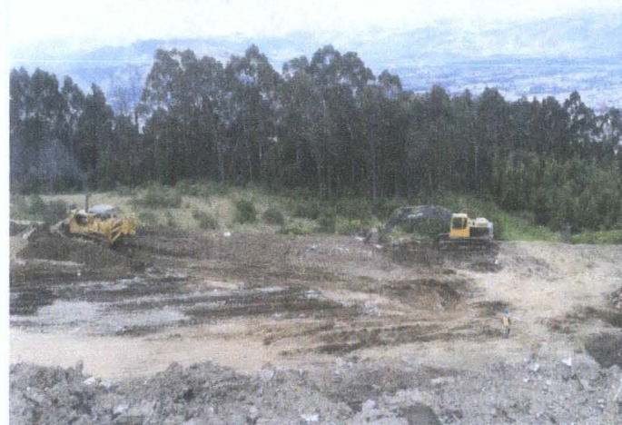
CONFORMACION DE PLATAFORMA
