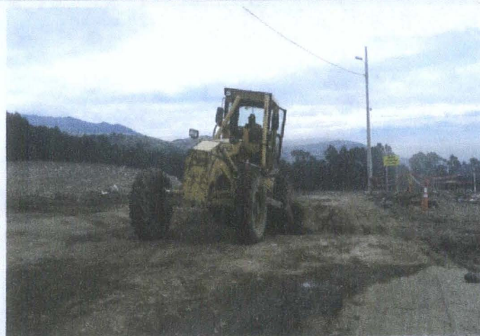
RECONFORMACION DE VIAS DE ACCESO
