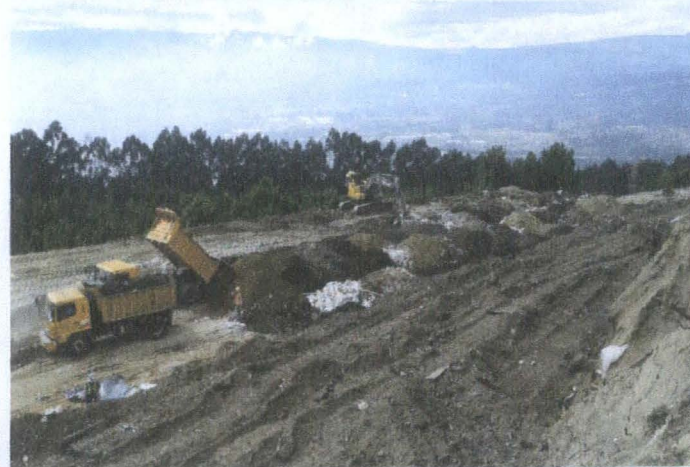
ACOPIO DE MATERIAL
