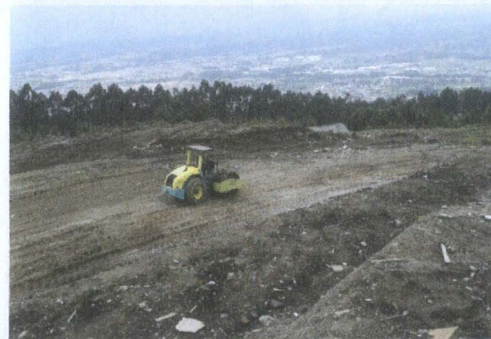
COMPACTACION CON RODILLO PATA DE CABRA
