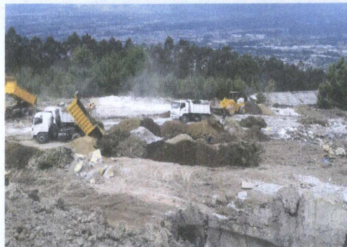
ACOPIO DE MATERIAL DE ESCOMBROS
