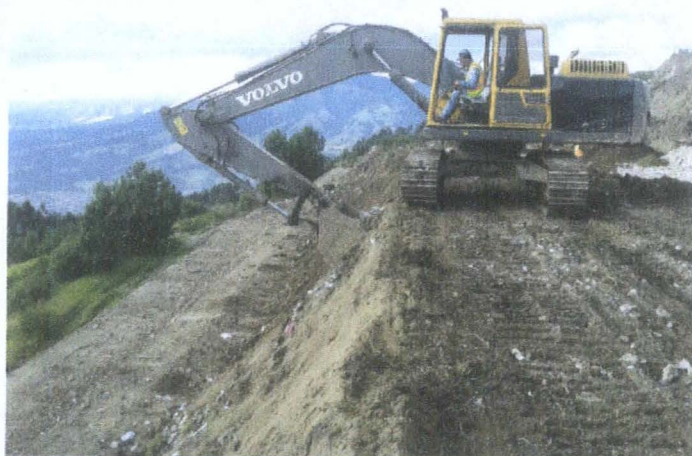
CONFORMACION DE TALUD
