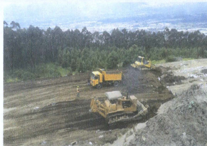
CONFORMACION DE TERRAPLEN
