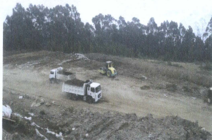
COMPACTACION CON RODILLO PATA DE CABRA
