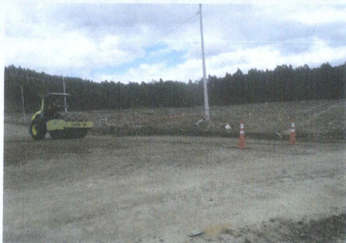
COMPACTACION CON RODILLO PATA DE CABRA
