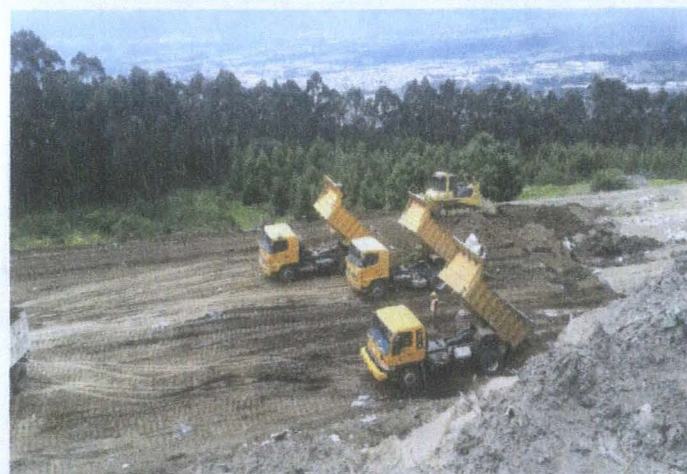
DESCARGA DE MATERIAL DE ESCOMBRO
