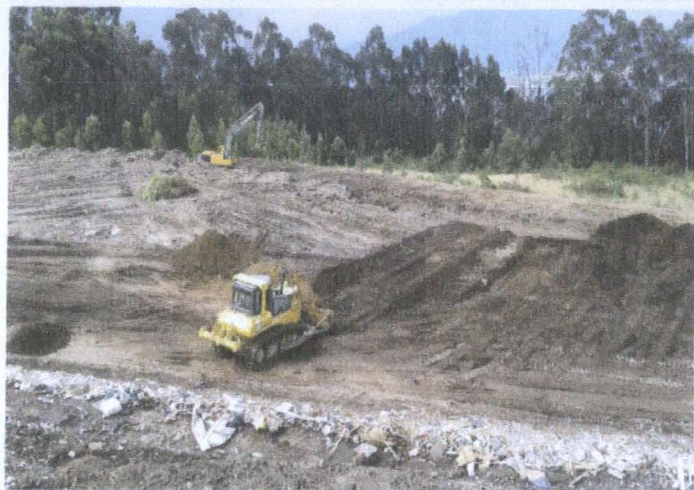
CONFORMACION PLATAFORMA
