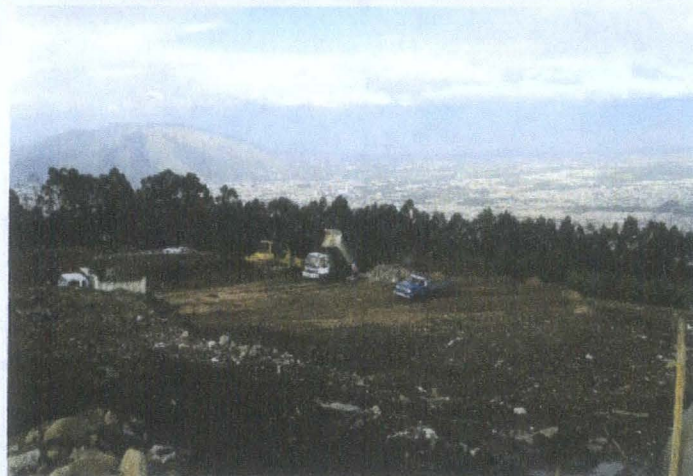
ACOPIO DE MATERIAL 2DA PLATAFORMA
