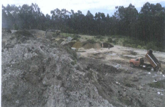
ACOPIO DE MATERIAL
