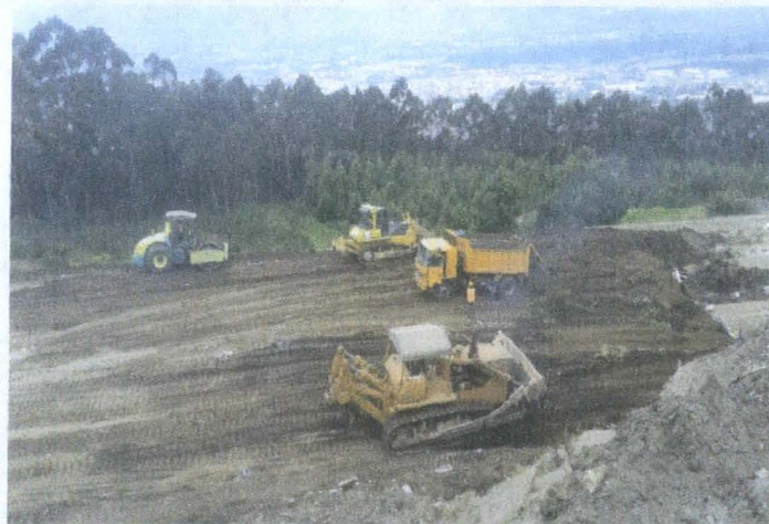
CONFORMACION DE TERRAPLEN
