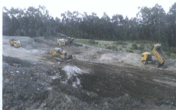
TENDIDO DE ESCOMBROS
