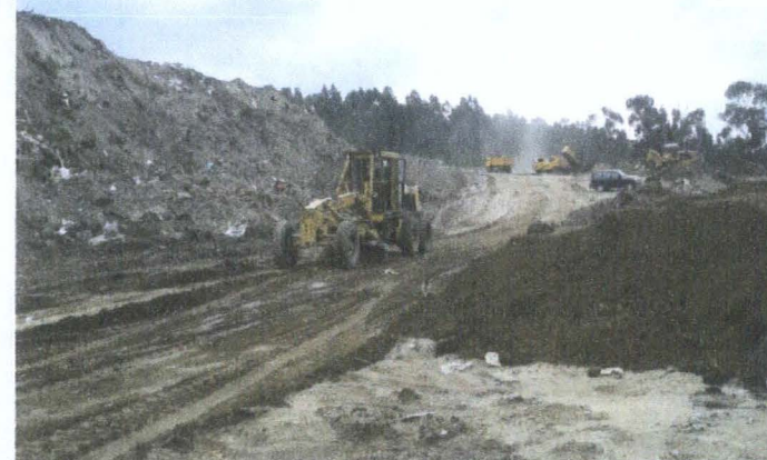
RASANTEO DE PLATAFORMA CON MOTONIVELADORA
