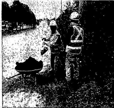
LIMPIEZA MANUAL DE CUNETA EN LA AV. SIMON BOLIVAR
