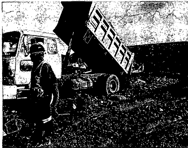
DESCARGA DE LODOS
