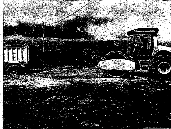
REALIZANDO COMPACTACION DE ESCOMBROS
