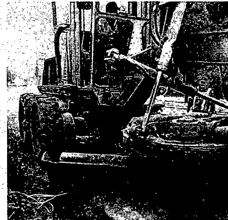
MOTONIVELADORA LIMPIANDO CUNETA EN AV. SIMON BOLIVAR
