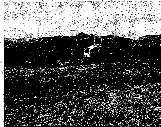
COMPACTADO DE ESCOMBRO TENDIDO
