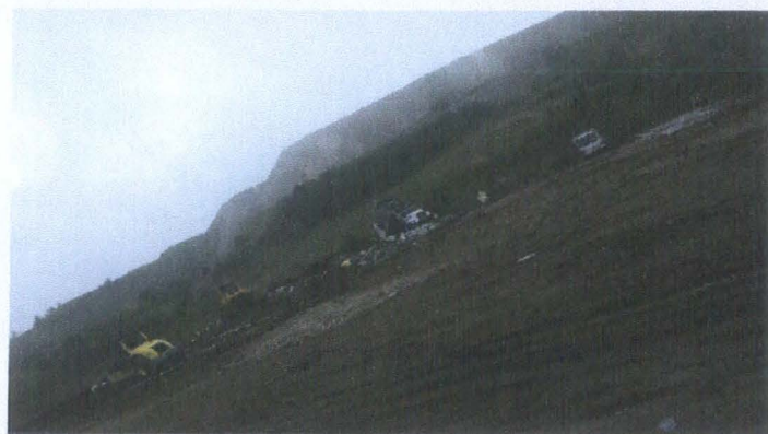
TENDIDO DE MATERIAL DE RELLENO Y COMPACTACION
