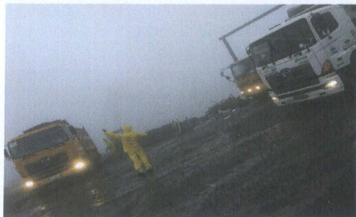
CONTROL DE VIAS DE ACCESO Y SALIDA PARA LA DISPOSICION DEL MATERIAL
