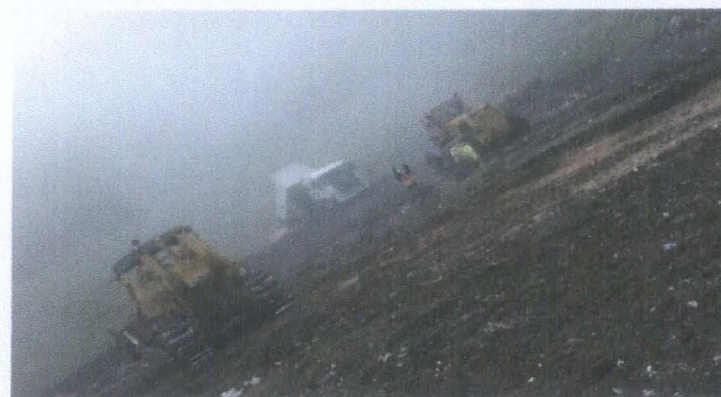
GUIAS RECIBIENDO EL ACOPIO DEL MATERIAL
