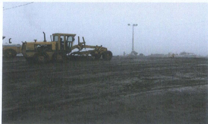
LIMPIEZA DE LODOS DE LAS VIAS DE ACCESOS Y SALIDAS
