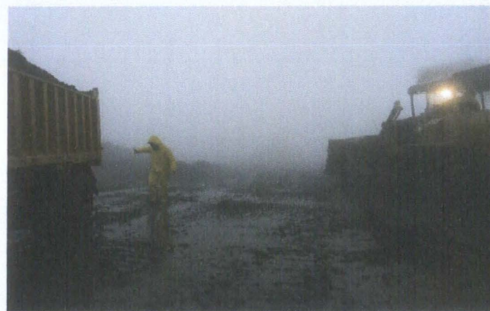
DISPOSICION Y TENDIDO DEL MATERIAL DURANTE UN DIA DE LLUVIAS
