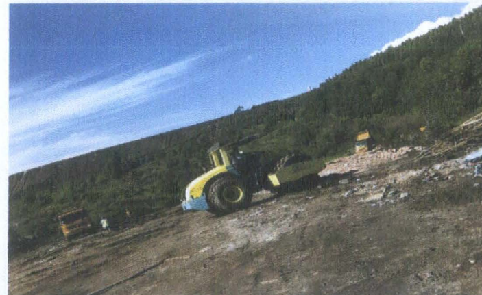
COMPACTACION DE PLATAF.DE EMERGENCIA HACIA LA PROLONGACION
