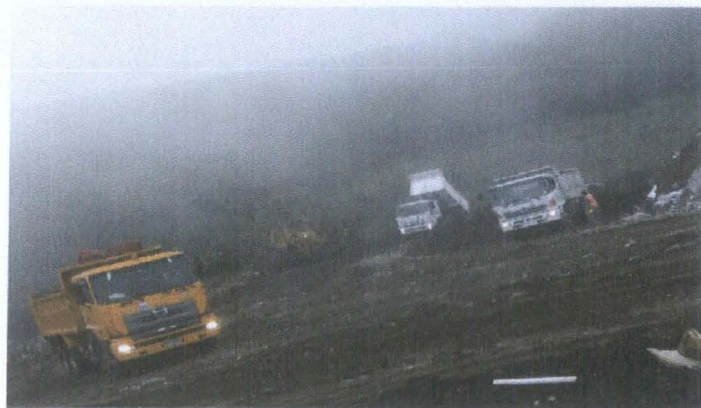
ACOPIO DE MATERIAL EN PLATAF. INFERIOR SECTOR SUR
