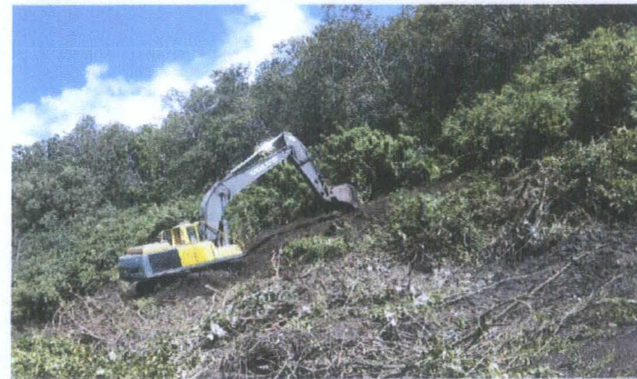
DESBROCE PARA PLATAFORMA DE ACOPIO
