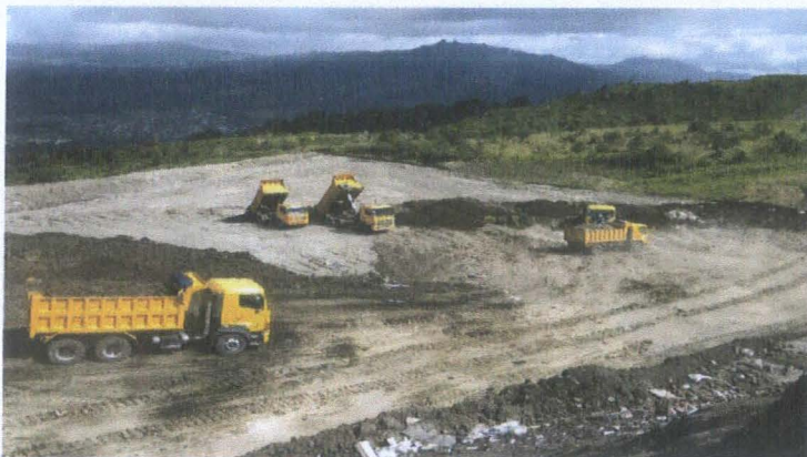
CONTINUACION DEL RELLENO EN LA PLATAFORMA INFERIOR SECTOR SUR
