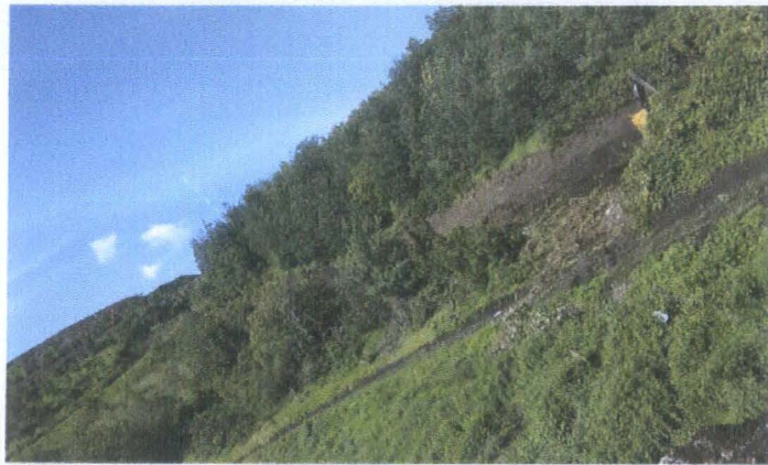
DESBROCE SECTOR SUR-OCCIDENTAL PARA PROLONGACION DE PLATAF.SUPERIOR
