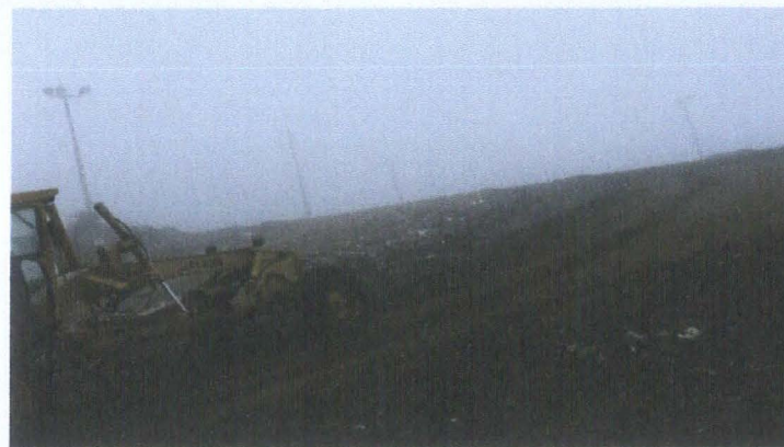
RASANTEO DEL RELLENO EN LA PLATAF. INFERIOR SECTOR SUR
