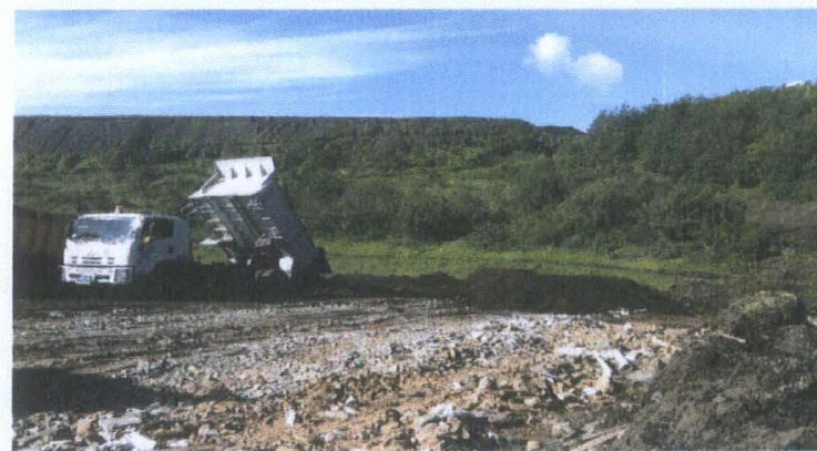
RELLENO Y ESTABILIZACION DE LA PROLONGACION DE LA PLATAFORMA DE EMERGENCIA
