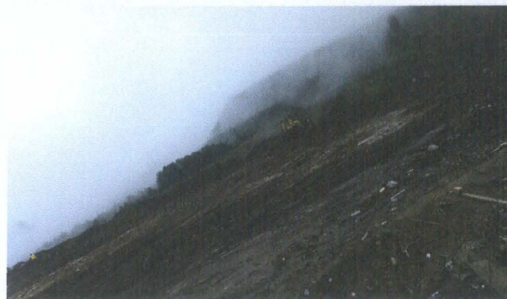
TENDIDO DEL MATERIAL EN PLATAF. DE EMERGENCIA
