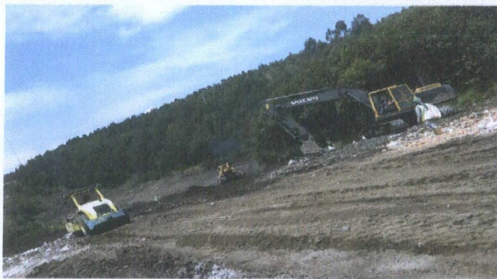
VIA DE ACCESO A LA PROLONGACION DE LA PLATAFORMA DE EMERGENCIA
