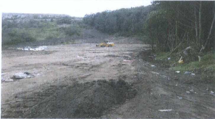
PROLONGACION DE PLATAFORMA DE MERGENCIA YA CONFORMADA
