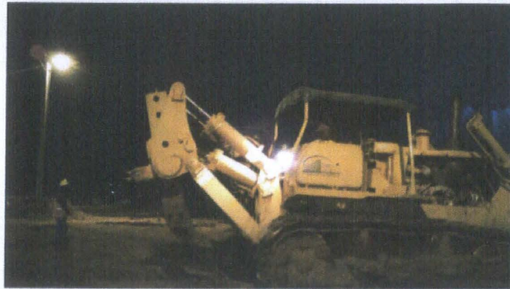
OPERACIÓN NOCTURNA, ACOPIO DE MATERIAL EN LA PLATAFORMA SUPERIOR
