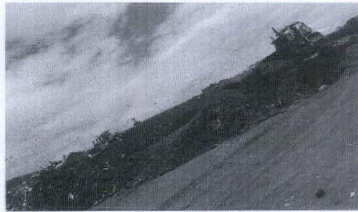
TENDIDO DEL MATERIAL PARA NVEL BERMA # 8
