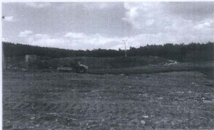
COMPACTACION DE PROLONG.PLATAFOR.PRINC.
