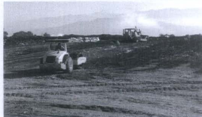
COMPACTACION DE MATERIAL
