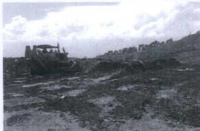
LIMPIEZA DE LODOS Y RECONFORMACION
