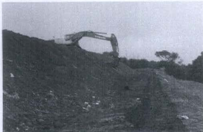
RECONFORMACION DE TALUD-BERMA # 7
