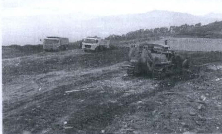
ACOPIO Y TENDIDO EN LA PLATAFORMA PRINCIPAL
