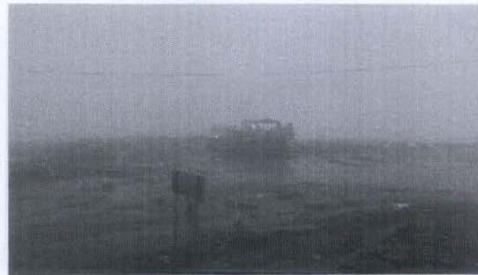
TENDIDO DE MATERIAL EN LA PLATAFORMA SUPERIOR EN UN DIA DE LLUVIA
