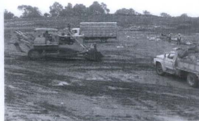
LIMPIEZA DE LODOS PLATAF.SUP.PRINCIPAL
