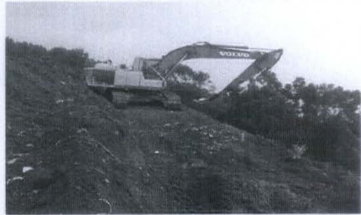
RECONFORMACION DE BERMA # 7
