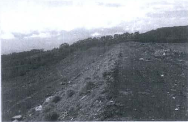
LIMPIEZA Y MANTEN. DE BERMAS Y TALUDES
