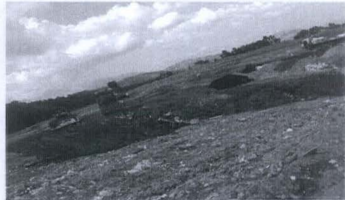
ACOPIO Y TENDIDO SOBRE PLATAFOR.PRINC.
