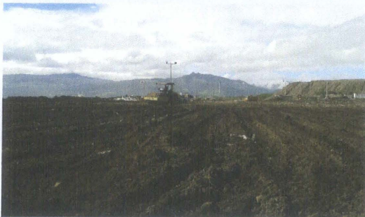
COMPACTACION CON RODILLO PATA DE CABRA
