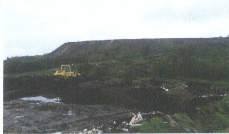
TENDIDO DEL MATERIAL EN PLATAFORMA NORTE
