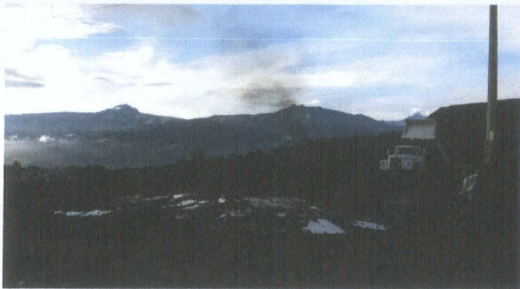
LIMPIEZA DE PLATAFORMA PARA RECIBIR MATERIAL
