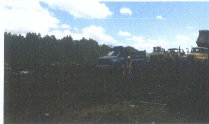
ACOPIO DE MATERIAL
