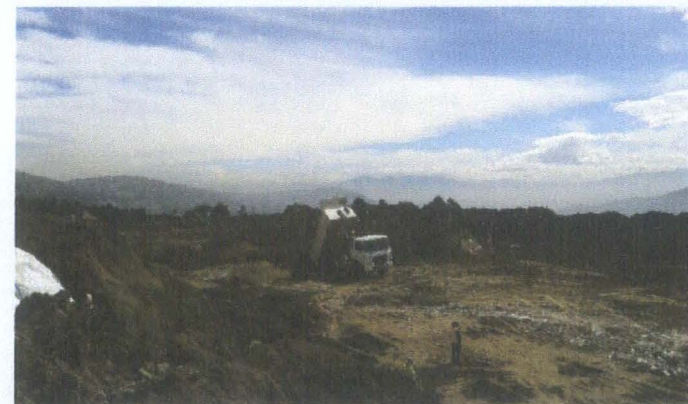
ACOPIO DE MATERIAL EN PLATAFORMA INFERIOR
