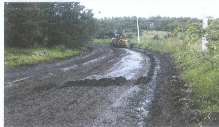
RASANTEO DE VIAS INTERNAS
