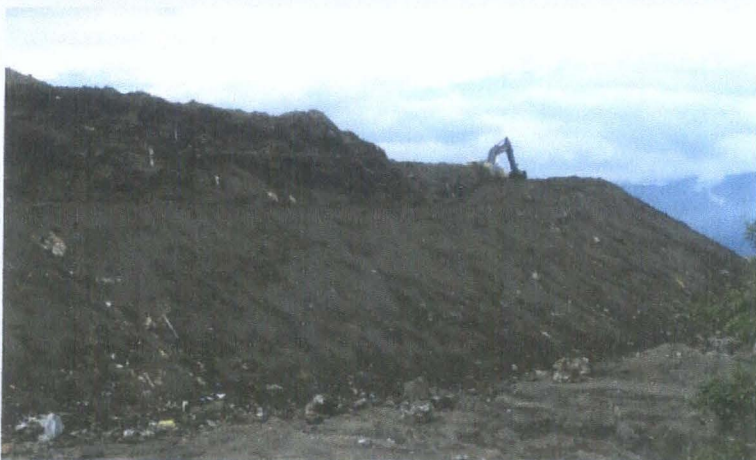
CONSTRUCCION DE BADENES
