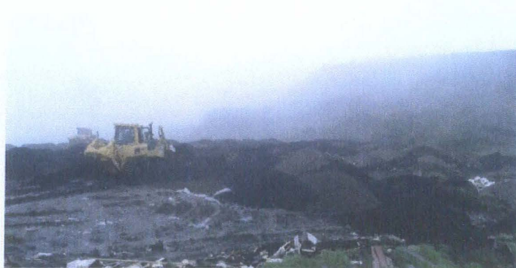
EMPUJE DE MATERIAL Y LODOS
