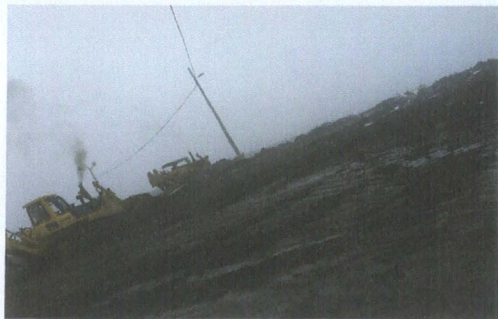
MANTENIMIENTO PLATAFORMA SUPERIOR
