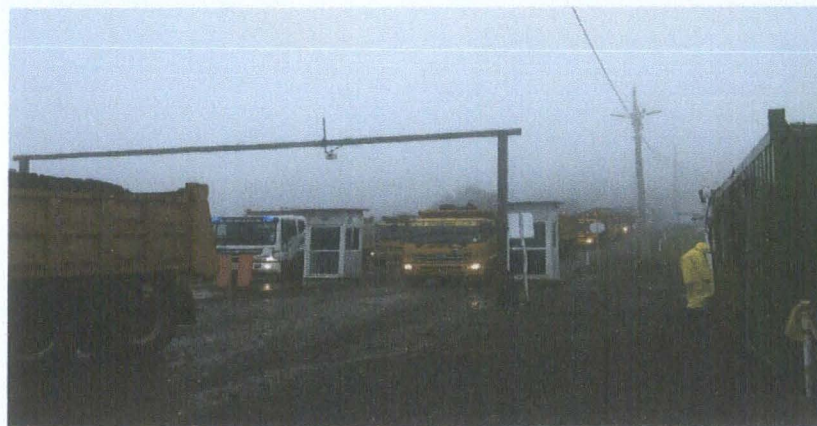
VOLQUETAS EN ESPERA POR LLUVIAS HASTA PREPARAR LA PLATAFORMA
