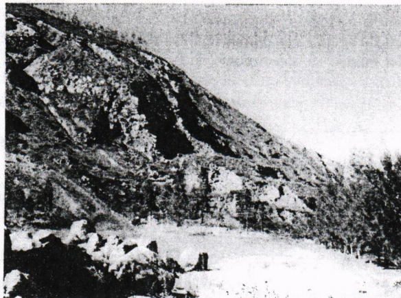
Foto 7.10. Vista margen derecha, bloques andesíticos. Mina Sr. Hernández.
