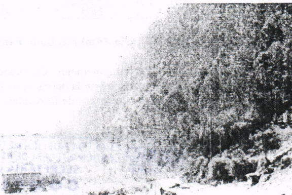
Foto 7.5. Vista panorámica talud derecho, lado Oeste. Relleno sanitario Zámbriza.
