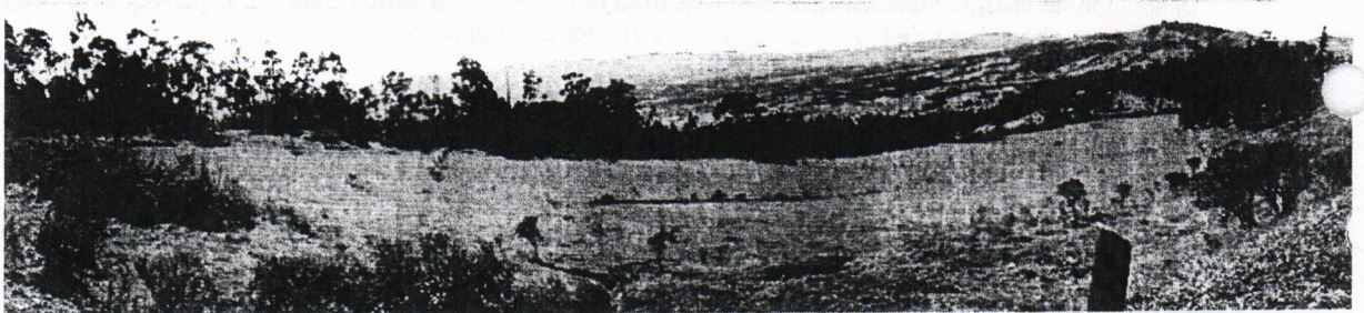
Foto 7.11. Vista panorámica, zona alta. Escombrera Av. Simón Bolívar II.
