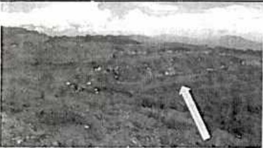
Bermas para estabilización del talud y construcción de colector para manejo de aguas superficiales provenientes de la Av Simón Bolívar
