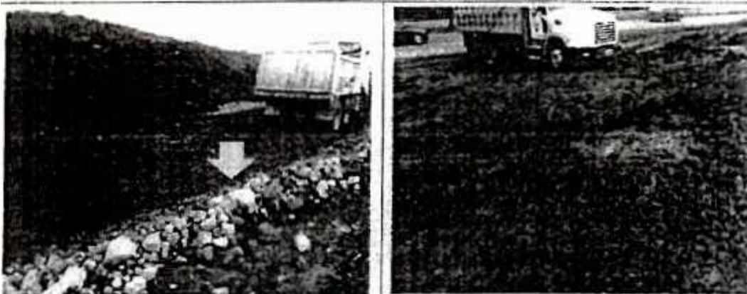
Imagen 3 y 4: Ingreso a Escombrera -- se ha colocado material de mejoramiento.
