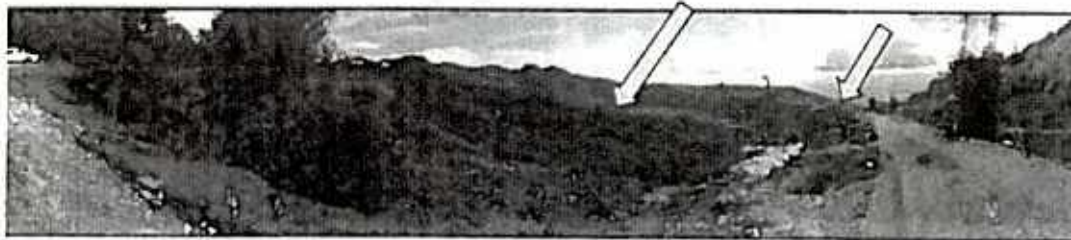
Bermas para estabilización del talud y construcción de colector para manejo de aguas superficiales provenientes de la Av Simón Bolívar
