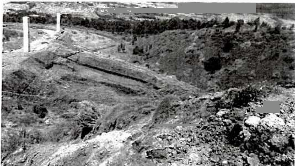
CUBETO CONSTRUIDO PARA RECEPCIÓN DE LODOS D E L )11.I RO.
