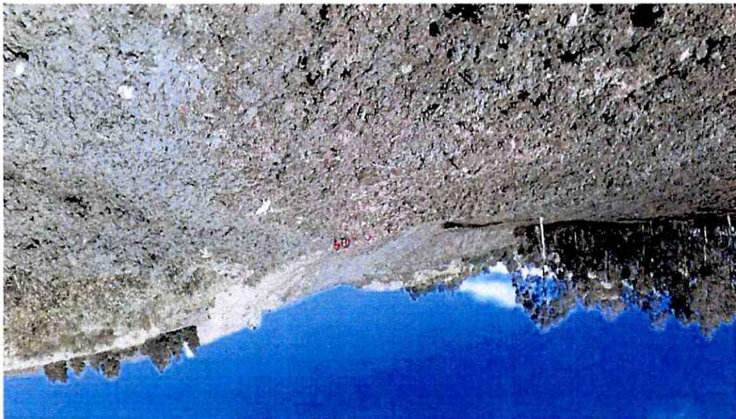
El día 6 de diciembre en horas de la madrugada se produjo un deslizamiento de tierra de aproximadamente 150.000 m3 sobre el canal del Sistema Pita en el sector de la escombrera El Troje provocando el taponamiento de 300 m. de canal y parcial destrucción de las paredes del canal (17 metros).
