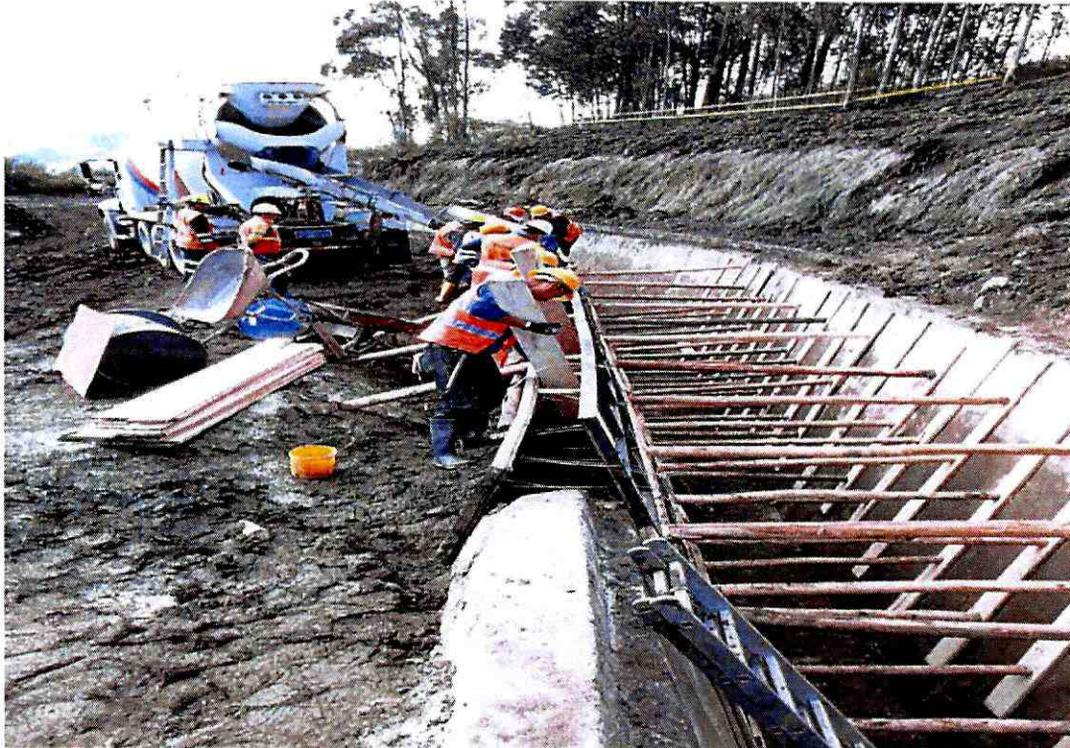
Luego de esperar el fraguado del hormigón a las 19h00 se solicitó se envíen los primeros 200 l/s por el canal, se realizó el auto lavado hidráulico del tramo afectado y posteriormente se fue incrementando paulatinamente el caudal enviado a las plantas.
