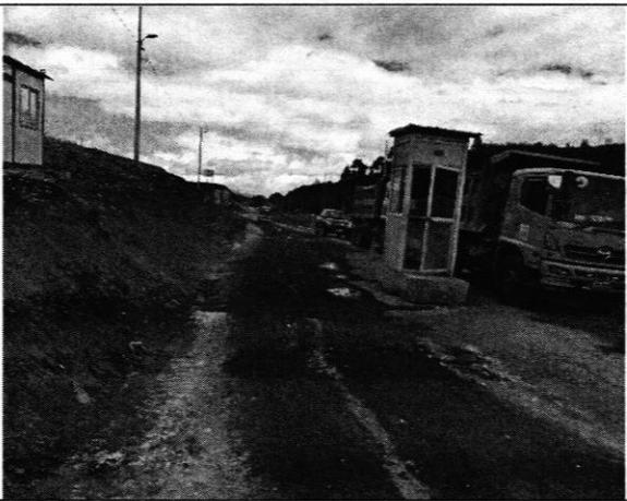
Foto 6: Humedecida la vía de acceso a la plataforma de descarga
