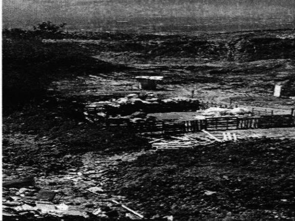
**Foto 2: Ampliación y humectación de la vía de acceso (caseta de cobro)**
