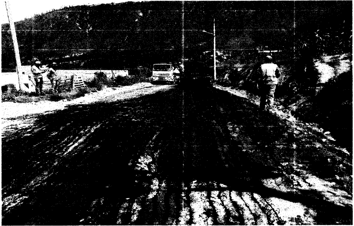
COLCACION DE EMULSION PARA CONTROL DE POLVO VIA ESCOMBRERA OYACOTO
