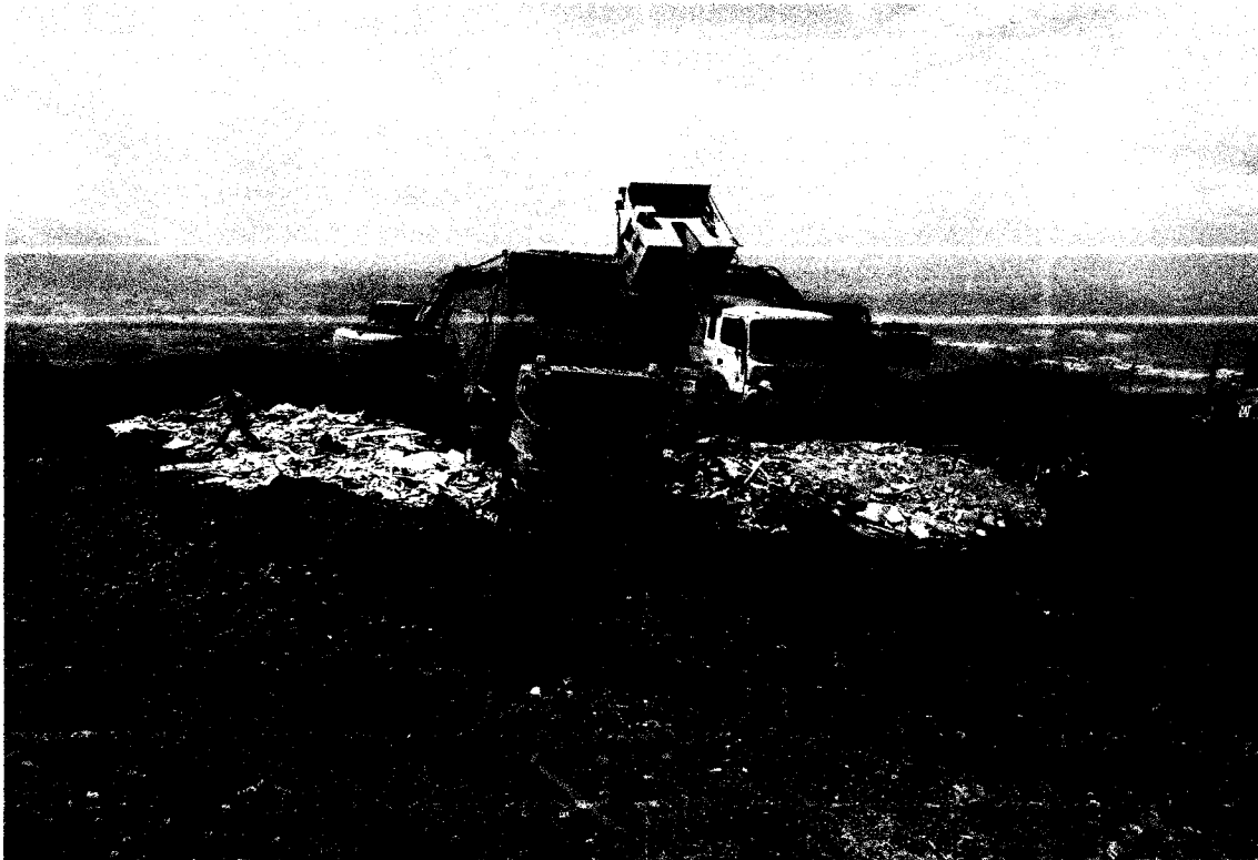
DESCARGAS DE ESCOMBROS Y LODOS PLATAFORMA SUR ALTA
