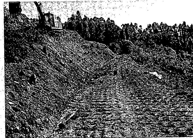
COMPACTACION DE BERMAS EN PIE DE TALUD
