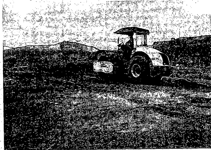
COMPACTACIÓN DE MATERIAL
