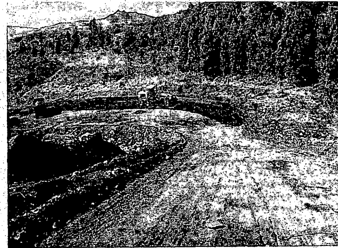
RASANTEO VIA DE ACCESO PLATAFORMA 4
