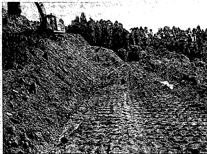
CONFORMACION DE BERMA EN PIE TALUD
