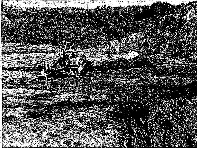
CONFORMACION DE PLATAFORMA 4
