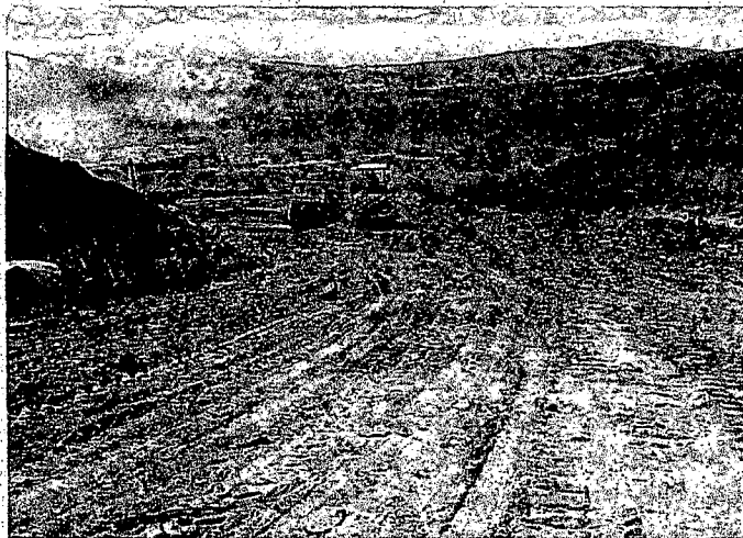
COMPACTACIÓN VÍAS DE ACCESO
