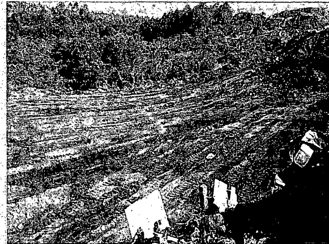
DESBROCE Y LIMPIEZA DE TERRENO
