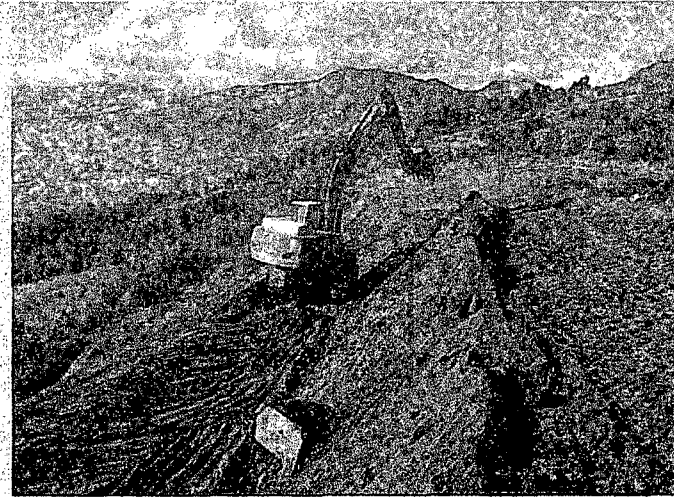
CONFORMACION DE BERMA MAESTRA
