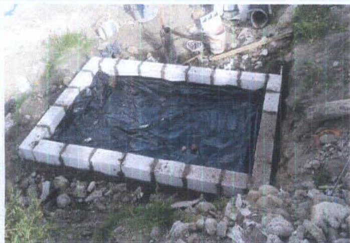
CONFORMACION CUBETO DE DIESEL
