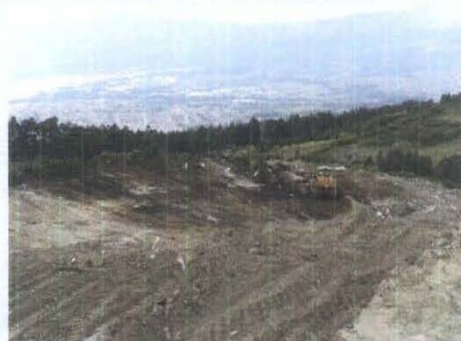
TENDIDO DE ESCOMBROS
