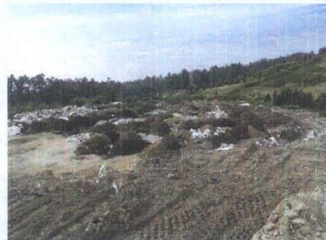
ACOPIO DE MATERIAL EN SITIO
