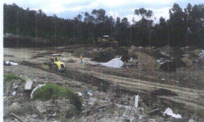
TENDIDO Y COMPACTACION DE MATERIAL
