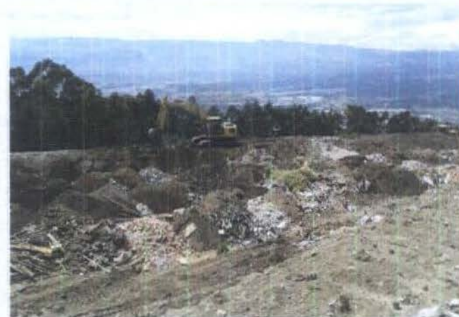
ACOPIO DE MATERIAL PARA CONFORMACION DE BERMA
