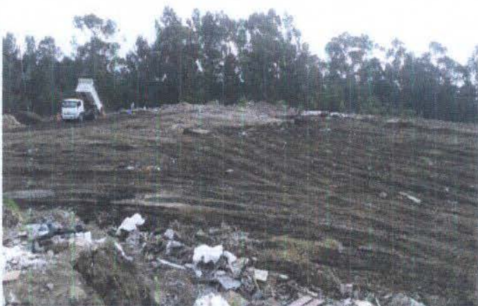
RELLENO 1ERA PLATAFORMA
