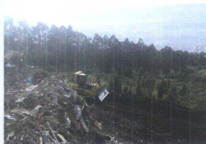
DES BROCE PARA REMATE DE BERMAS
