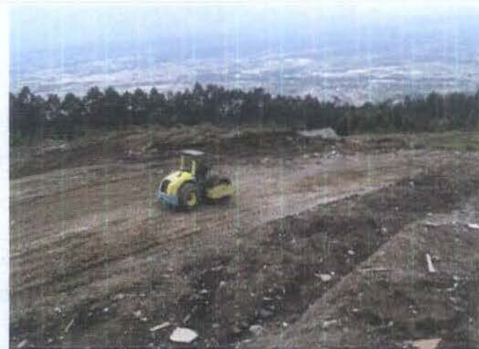
COMPACTACION CON RODILLO PATA DE CABRA
