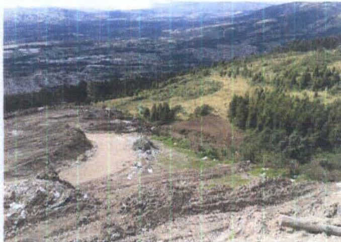
DESBROCE PARA RELLENO DE QUEBRADA
