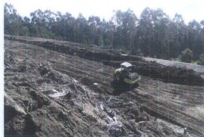
COMPACTACION CON RODILLO PATA DE CABRA
