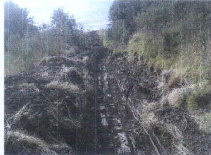
ZANJADO PROVISIONAL PARA AGUAS LLUVIA
