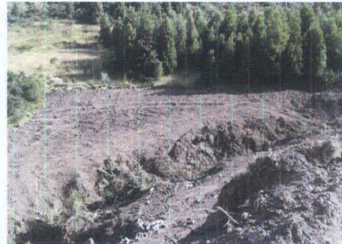
RELLENO DE QUEBRADA
