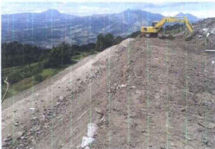
CONFORMACION 4TA BERMA
