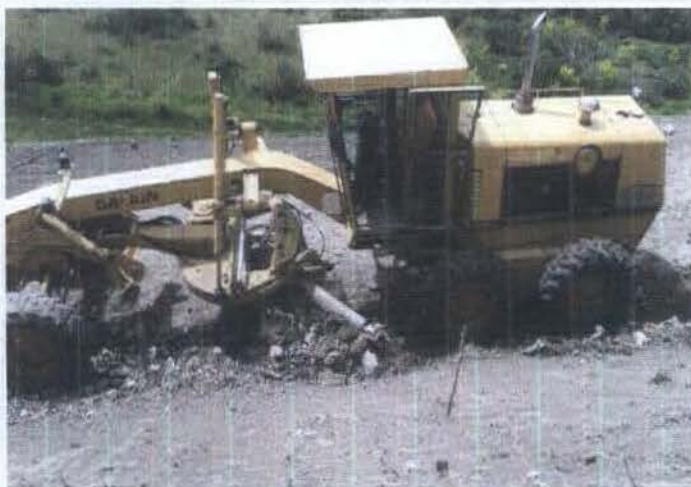
LIMPIEZA DE BERMA
