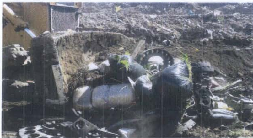
TENDIDO Y MEZCLA DE MATERIALES HETEROGENEOS EN PLATAFORMA SUR
