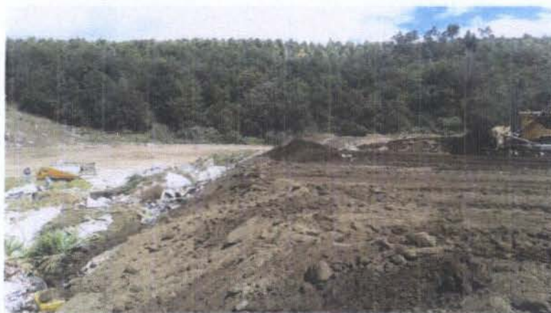
RELLENO PLATAFORMA INFERIOR SUR
