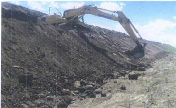
"PEINADO" DE TALUD EN BERMA No. 13 SECTOR ESTE DE ESCOMBRERA
