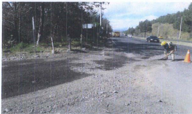
MANTENIMIENTO VIAL AL INGRESO DE ESCOMBRERA
