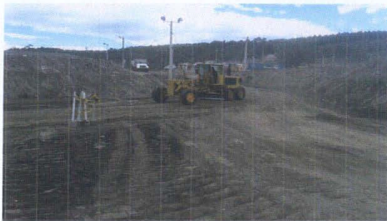
MANTENIMIENTO VIAL DE ACCESOS A PLATAFORMA ESTE
