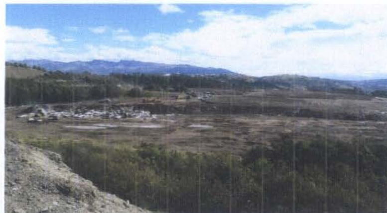
DISPOSICION DE MATERIALES EN ESCOMBRERA, SECTOR SUR
