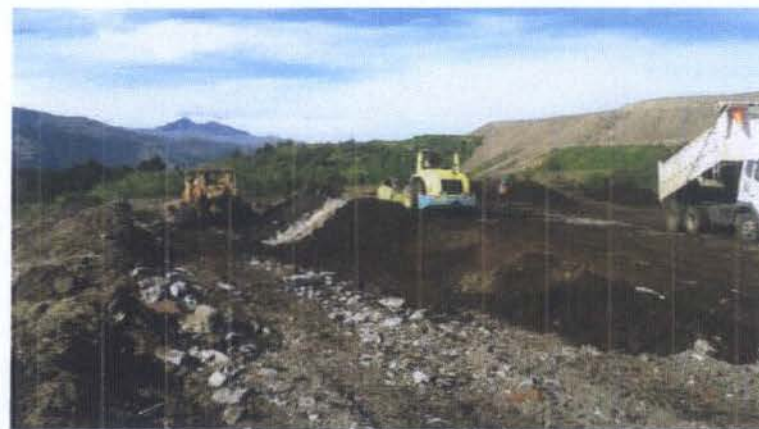
DISPOSICIÓN DE MATERIALES, TENDIDO Y COMPACTACIÓN EN PLATAFORMA ESTE
