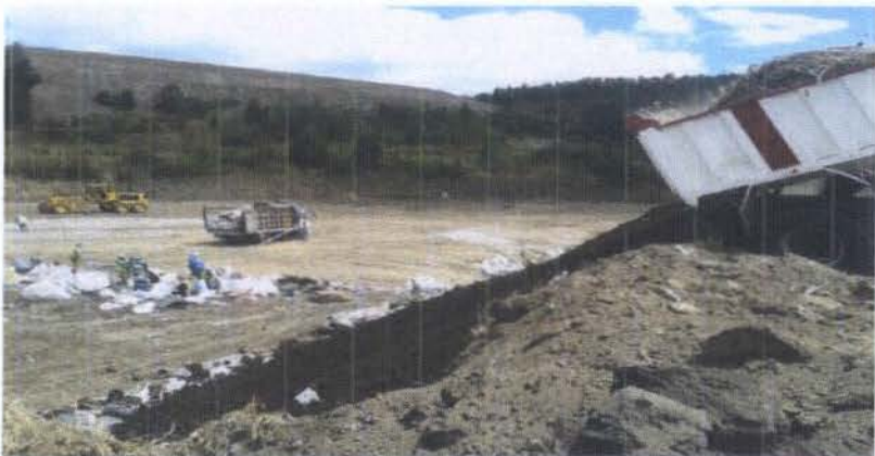
MEZCLA DE MATERIALES PARA CONSTRUCCIÓN DE RELLENO, SECTOR SUR
