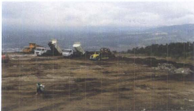
VOLQUETAS DESCARGANDO MATERIALES EN PLATAFORMA ESTE
