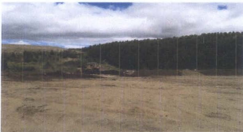
DESCABEZADO DE PRIMER BANCO DE TIERRA PARA RELLENO
