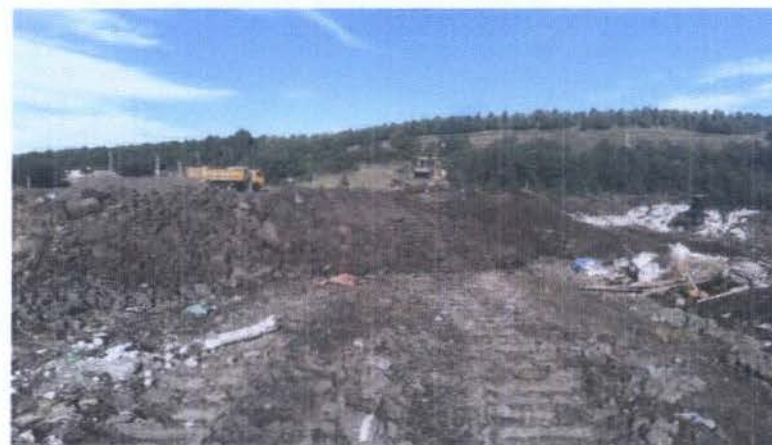
TENDIDO DE LODOS SECTOR NORTE DE ESCOMBRERA
