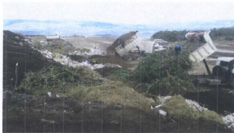
DISPOSICION DE MATERIALES HETEROGENEOS EN PLATAFORMA INFERIOR, SECTOR SUR.
