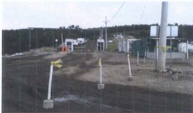
INGRESO DE VOLQUETAS A ESCOMBRERA Y SEÑALIZACION DE TRAFICO HACIA PLATAFORMAS
