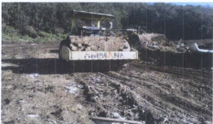
TENDIDO Y COMPACTACIÓN DE MATERIALES EN PLATAFORMA SUR
