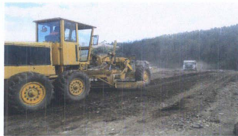
MANTENIMIENTO VIAL DE ACCESOS A PLATAFORMA SUR
