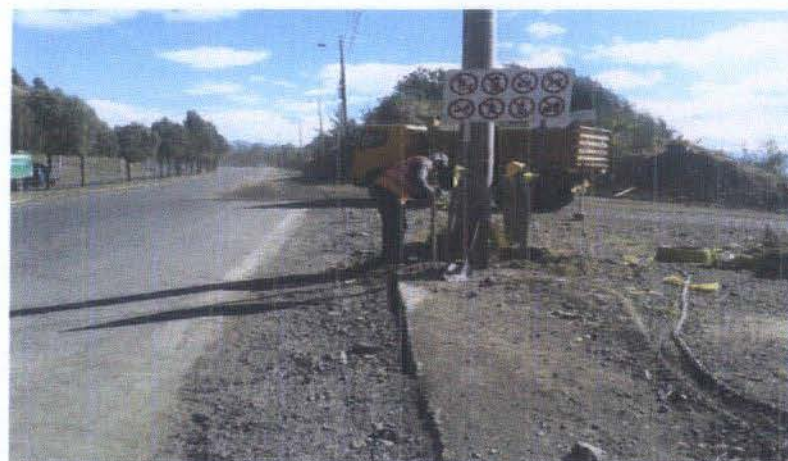
TRABAJOS DE MANTENIMIENTO AL INGRESO DE ESCOMBRERA
