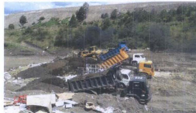
VOLQUETAS REALIZANDO DESCARGA ORDENADA DE MATERIALES EN PLATAFORMA SUR
