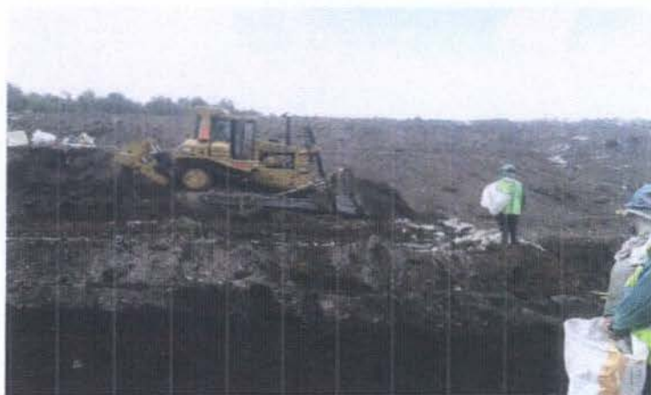
TENDIDO Y MEZCLADO DE MATERIALES EN PLATAFORMA SUR
