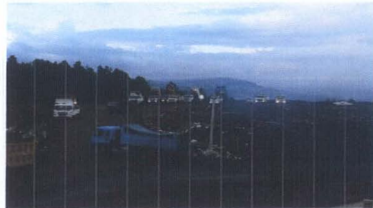
VOLQUETAS DEPOSITANDO LODOS EN PLATAFORMA NORTE. HORARIO NOCTURNO
