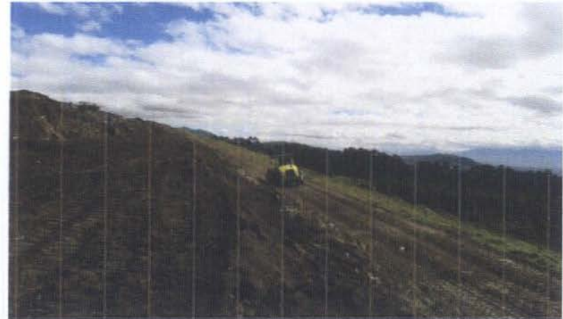
COMPACTACIÓN DE BERMAS, SECTOR ESTE ESCOMBRERA
