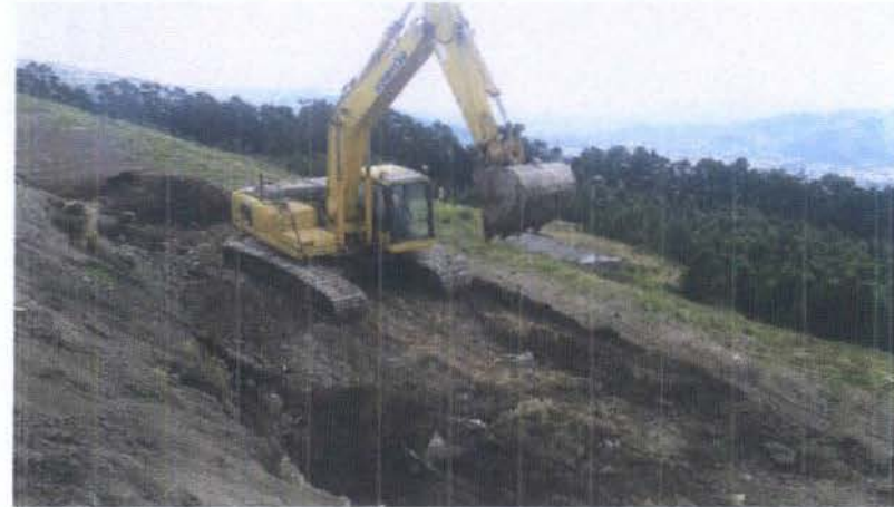
CONSTRUCCIÓN DE BERMAS, SECTOR ESTE DE ESCOMBRERA
