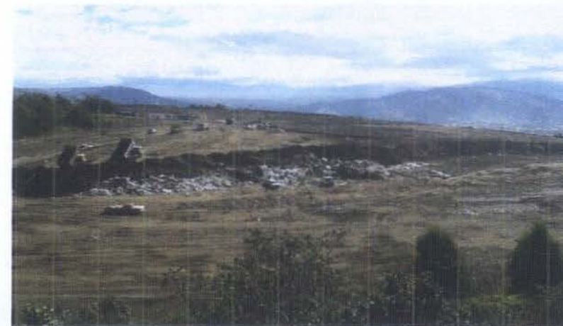
COMPROBACIÓN DEL ESTADO ACTUAL DE LA ESCOMBRERA. SE APRECIA PENDIENTES TRANSVERSALES Y LONGITUDINALES DEL ORDEN DE 4-5%
