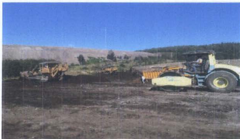
TENDIDO Y COMPACTACIÓN DE MATERIALES EN PLATAFORMA ESTE
