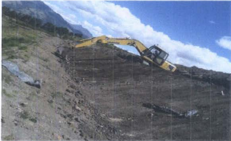
ESTABILIZACIÓN DE TALUDES Y CONSTRUCCIÓN DE BERMAS, SECTOR ESTE ESCOMBRERA
