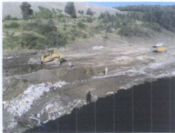
TENDIDO DE ESCOMBROS EN PLATAFORMA SUR
