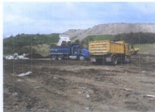
VOLQUETAS REALIZANDO LA DESCARGA
