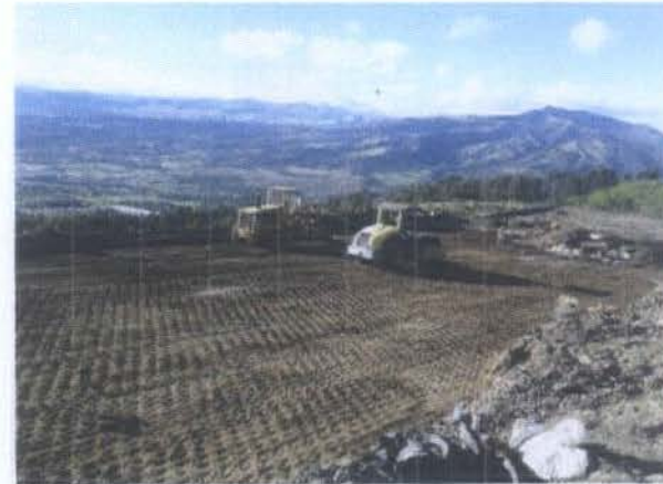
RECONFORMACION Y COMPACTACION DE MATERIALES EN PLATAFORMA ESTE
