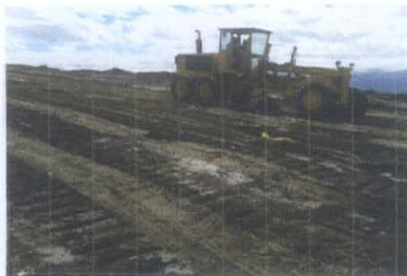
RECONFORMACION DE ACCESOS PLATAFORMA ESTE
