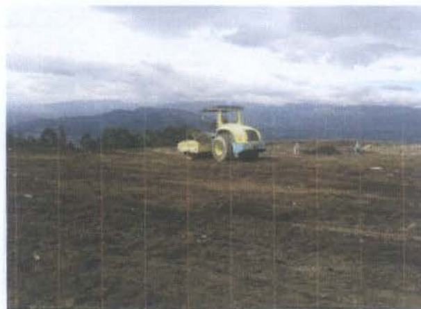
COMPACTACION DE MATERIALES Y ESCOMBROS PLATAFORMA ESTE
