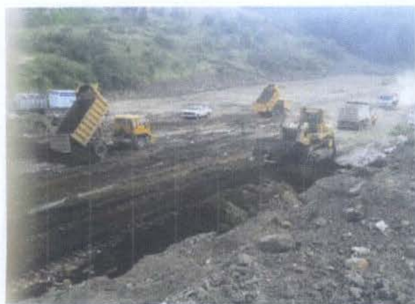
DISPOSICION DE ESCOMBROS EN LA PLATAFORMA SUR BAJA DE LA ESCOMBRERA
