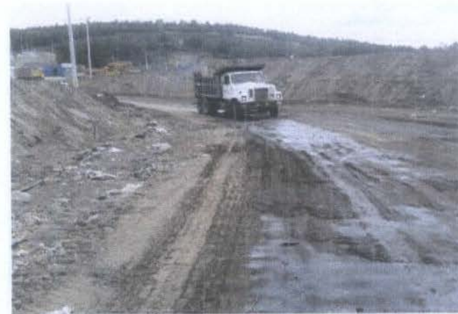
CONTROL DE POLVO AL INTERIOR DE ESCOMBRERA
