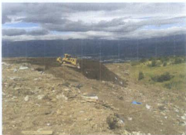
TENDIDO DE ESCOMBROS PLATAFORMA SUR
