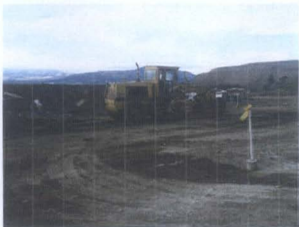
CONSTRUCCION CUNETETA LADO DERECHO ACCESO PLATFORMA SUR
