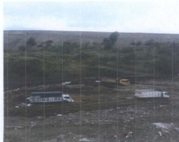
DISPOSICION DE ESCOMBROS PLATAFORMA SUR
