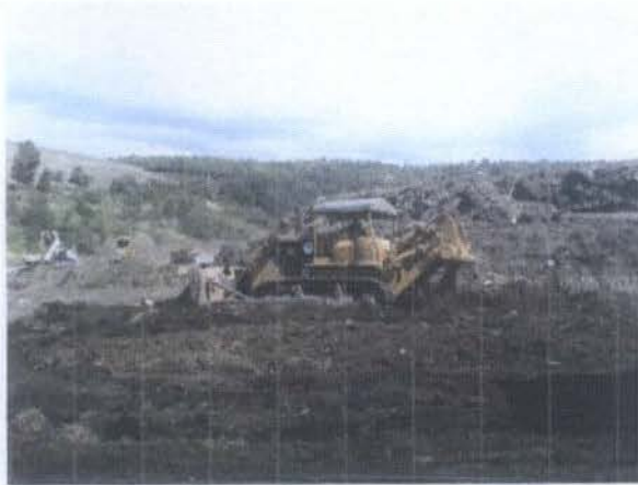
TENDIDO DE MATERIALES EN PLATAFORMA ESTE
