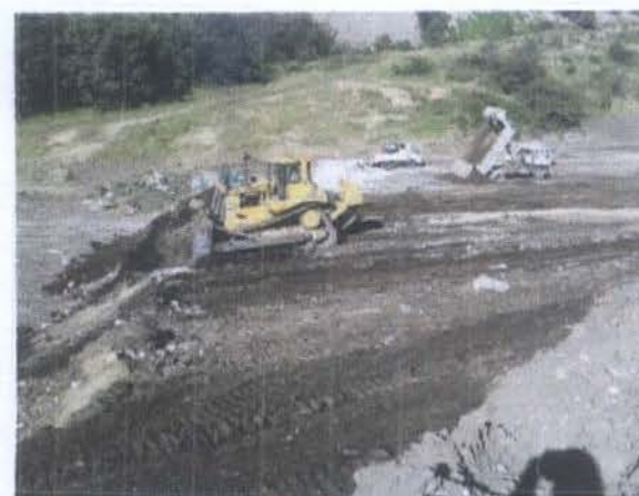
TENDIDO DE ESCOMBROS EN LA PLATAFORMA SUR BAJA DE LA ESCOMBRERA
