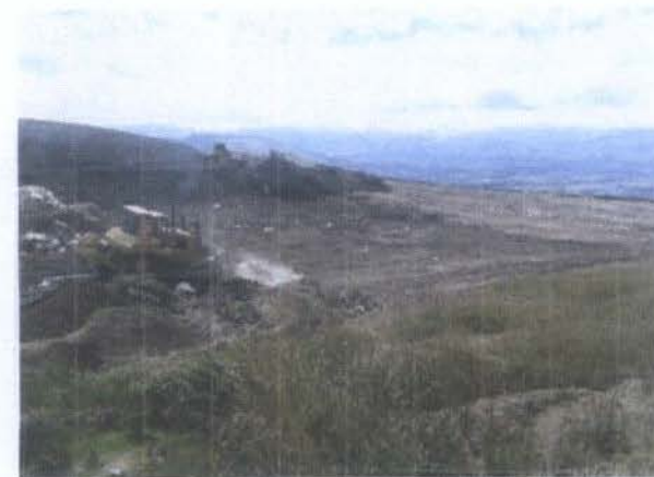
TENDIDO DE MATERIALES EN PLATAFORMAS SUR Y ESTE
