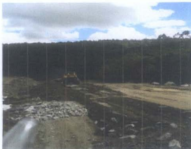
APERTURA DE ACCESOS PLATAFORMA SUR
