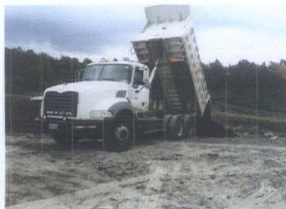
VOLQUETAS DESCARGANDO LOS ESCOMBROS
