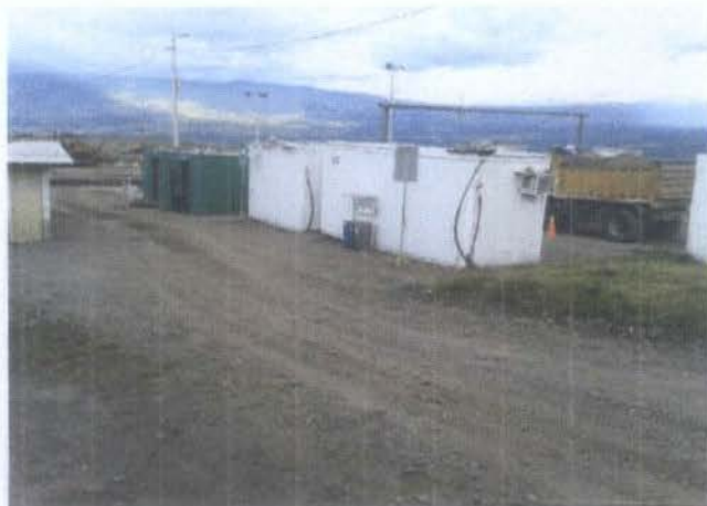
ORDEN Y LIMPIZA DE CAMPAMENTO ADJUNTO A CAMPERS OFICINAS
