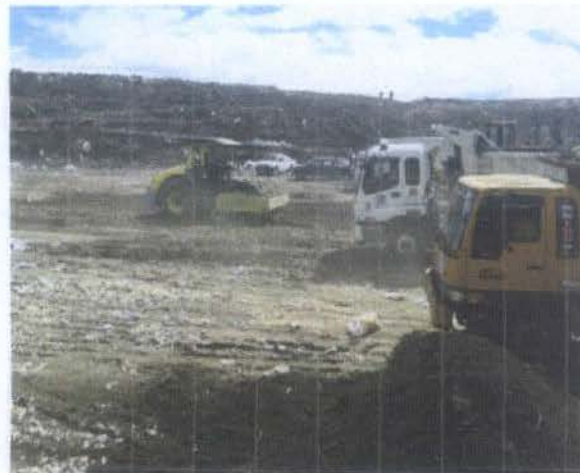
COMPACTACION DE ESCOMBROS EN PLATAFORMA SUR
