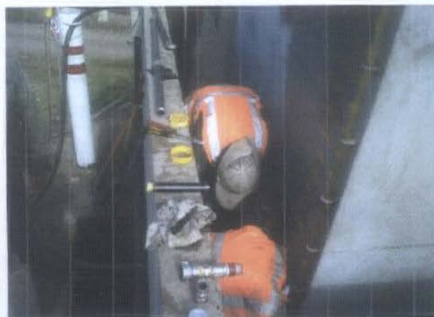
REPARACION DE FUGAS EN TANQUE DE COMBUSTIBLE
