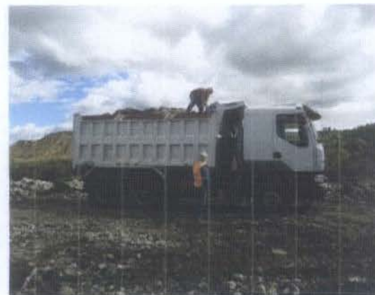
VOLQUETA RETIRANDO LA CUBIERTA DE LONA
