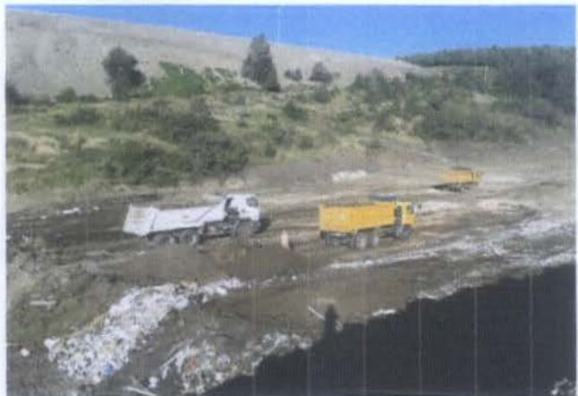
DESCARGA DE ESCOMBROS EN PLATAFORMA SUR
