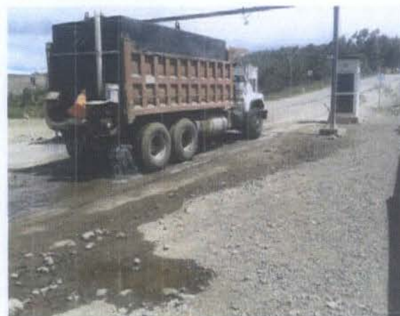
CONTROL DE POLVO EN PUESTOS DE CONTROL (INGRESO)
