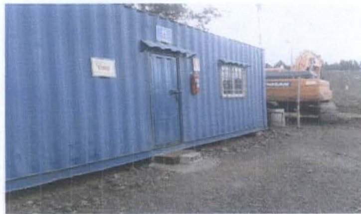
COLOCACION DE EXTINTORES Y CONSTRUCCION DE GRADA ACCESO COMEDOR
