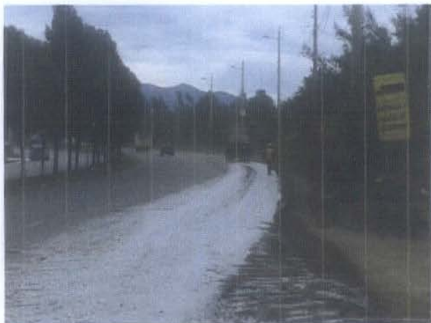
CONTROL DE POLVO EN LA AV. SIMON BOLIVAR EXTERIOR ESCOMBRERA
