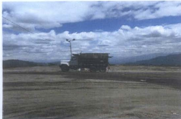
CONTROL DE POLVO CON TANQUERO DE AGUA SOBRE PLATAFORMAS
