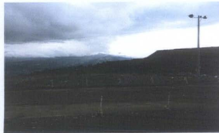
RECONFORMADA Y ESTABILIZADA LA PLATAFORMA DE EMERGENCIA
