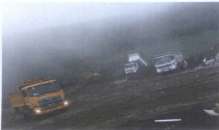
ACOPIO DE MATERIAL EN PLATAF. INFERIOR SECTOR SUR
