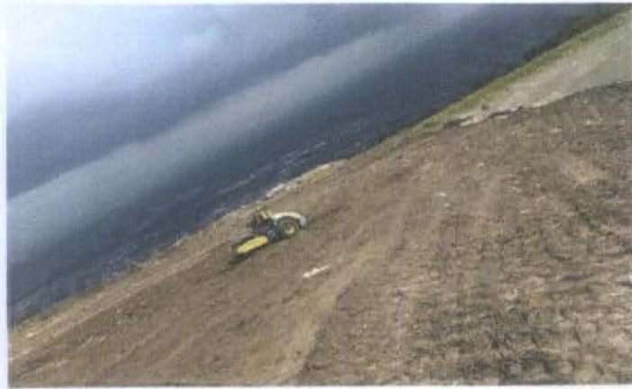
COMPACTACION DE TODA LA PLATAFORMA PRINCIPAL DE RELLENO
