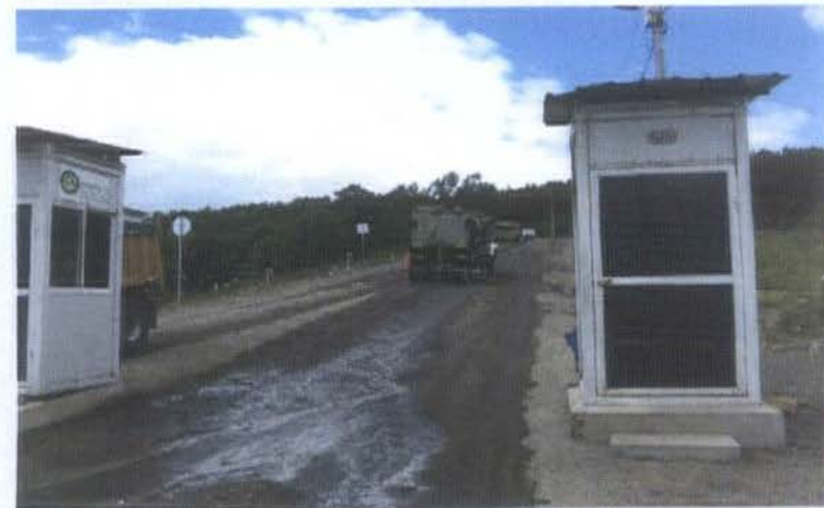
CONTROL DE POLVO AREA DEL CAMPER E NGRESO PRINCIPAL A LA ESCOMBRERA
