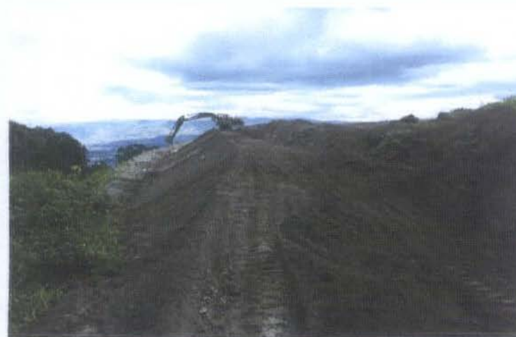
CONFORMACION DE LA BERMA 8 SECTOR NORTE DE LA PLATAFORMA PRINCIPAL
