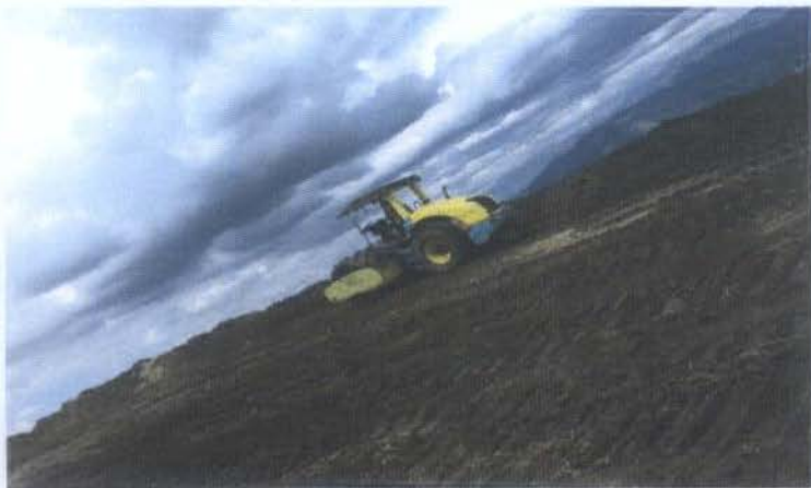
COMPACTACION PARA LA BERMA # 8 CON RODILLO PATA DE CABRA
