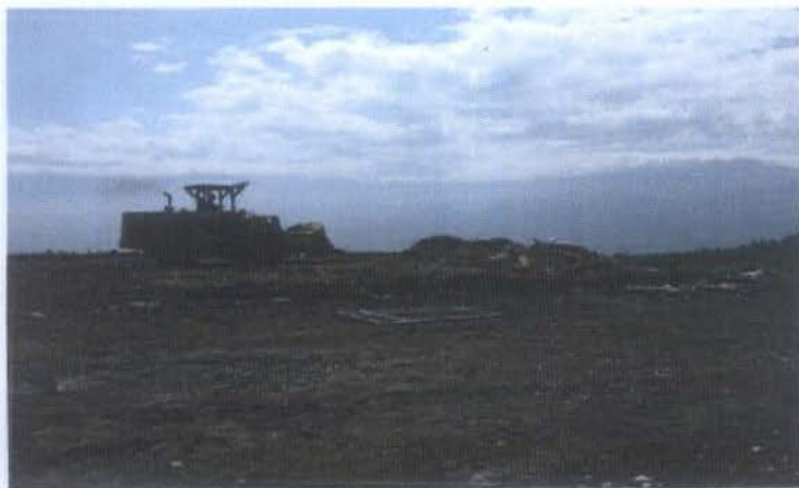
MEJORAMIENTO DE LA PLATAF.DE EMERGENCIA EN DIAS DE LLUVIAS
