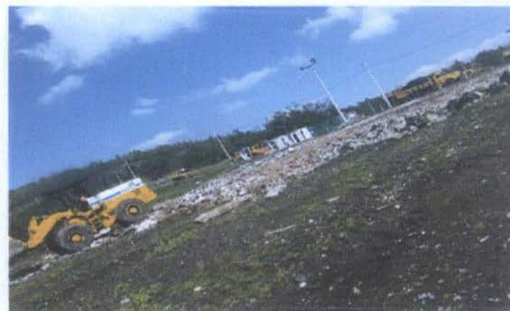
TENDIDO DE MATERIAL SUB-BASE PARA ESTABILIZACION DE PLATAF.DE EMERGENCIA
