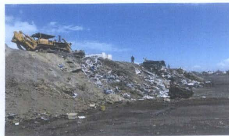
MEZCLA DEL MATERIAL CON ESCOMBROS
