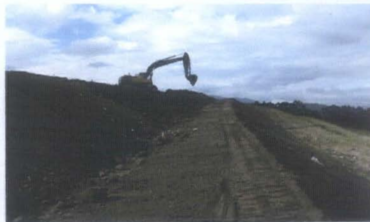
CONFORMACION DE BERMAS 7 Y 8
