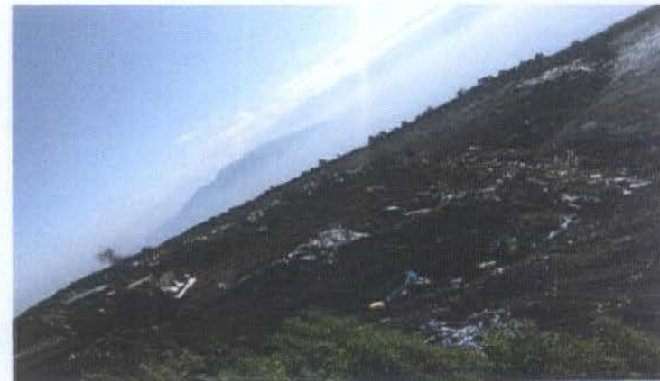
TENDIDO DEL MATERIAL, PLATAF. PRINCIPAL
