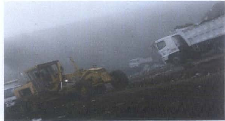
RASANTEO DE LA PLATAFORMA PRINCIPAL CON MOTONIVELADORA
