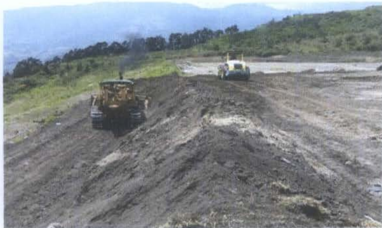
CONFORMACION DE BERMAS 7 Y 8 EN EL SECTOR SUR DE LA PLATAF.PRINCIPAL
