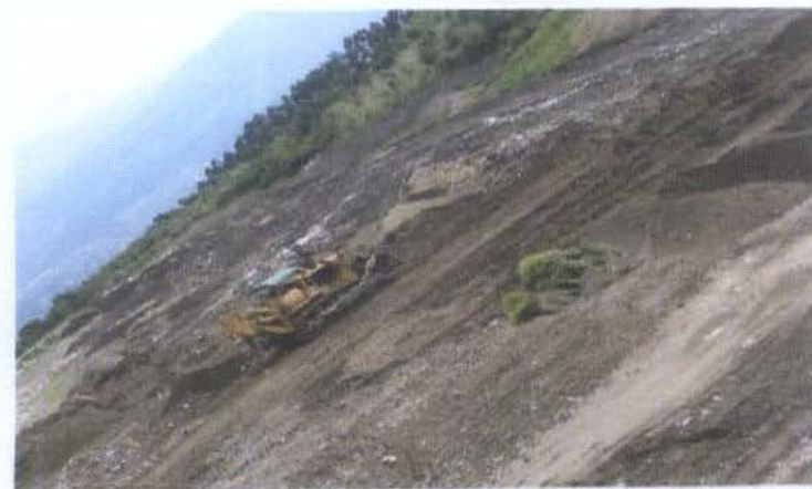
TENDIDO DEL MATERIAL EN LA PLATAFORMA INFERIOR SECTOR SUR
