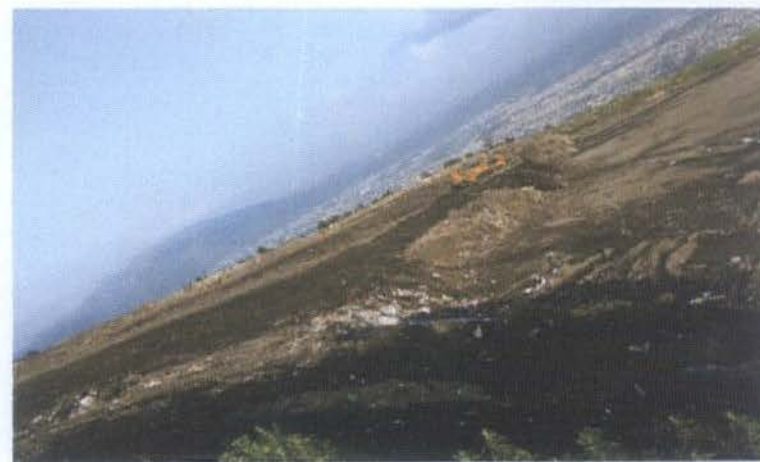
PROLONGACION DE LA PLATAF.PRINCIPAL SOBRE LA PLATAF.INFERIOR
