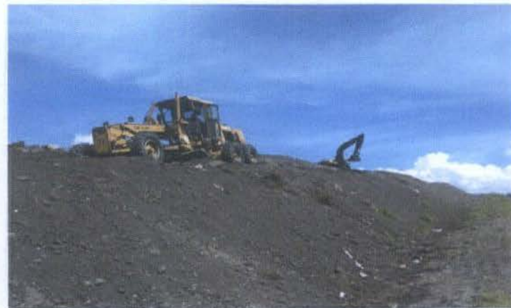
RASANTEO DE LA EXTENSION DE LA BERMA # 7
