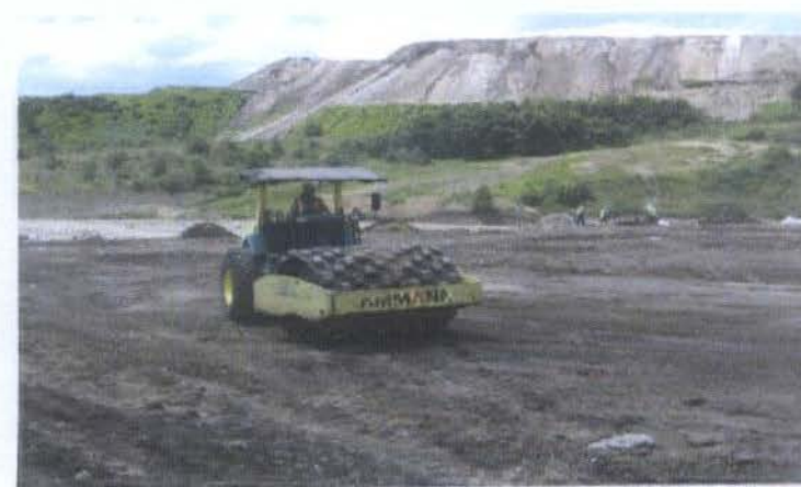
COMPACTACION DEL RELLENO SOBRE LA PLATAFORMA PRINCIPAL
