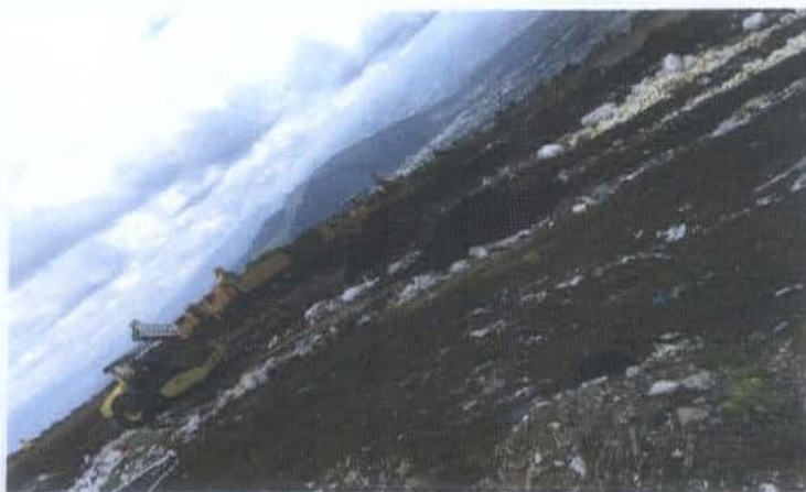
ACOPIO, TENDIDO Y COMPACTACION DEL MATERIAL
