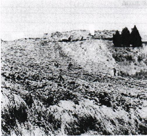
**Foto 6:** Se realizan cunetas de coronación en la parte superior de la escombrera para prevenir otros deslizamientos en caso de lluvias.
