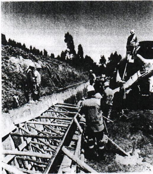
**Foto 8:** Retiro de material deslizado
