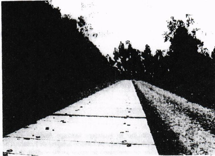
Fotografía 3: Zona baja Canal Pita, Se puede verificar todo el canal tapado con losetas prefabricadas
