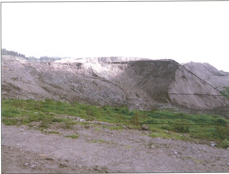
Foto 1 Vista del lado norte del dique destruido. Talud del dique: 2H:1V y del suelo bajo el dique de 8H:1V. Nótese el flujo de los lodos que estuvieron saturados al momento de la rotura y fluyeron ladera abajo. VJ 2017/12/07
