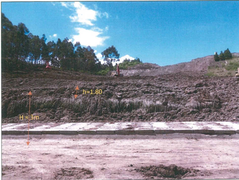
Foto 4 Altura aproximada d la lámina de lodo sobre el suelo natural: h \approx 1.80\text{m} . Altura del lodo sobre la vía: H \approx 3\text{m} . Centro-abajo: coberturas de hormigón sobre el Canal de agua para Quito. VJ 2017/12/07
