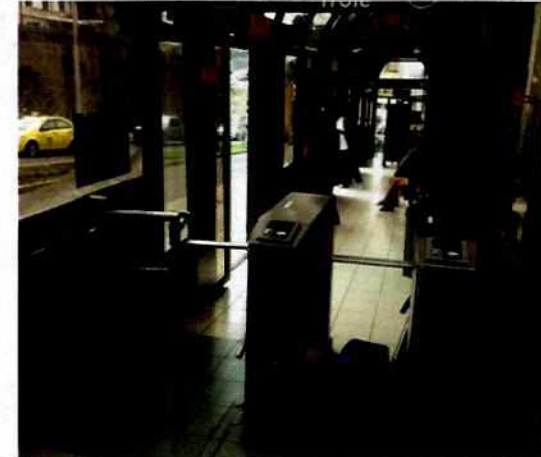
Pisos sin antideslizante y bandas podotáctiles
