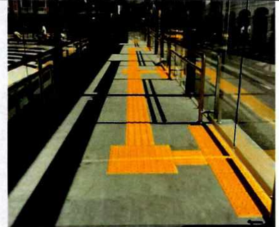
Pisos antideslizantes, apoyos isquiáticos y bandas podotáctiles
