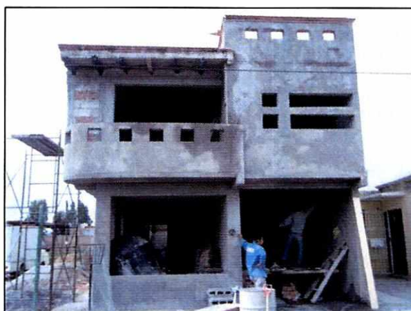
Ilustración 17 Ejemplo de una construcción " en obra gris"
