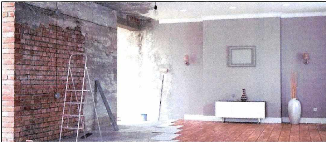
Ilustración 18 Ejemplo de una construcción " en acabados"
