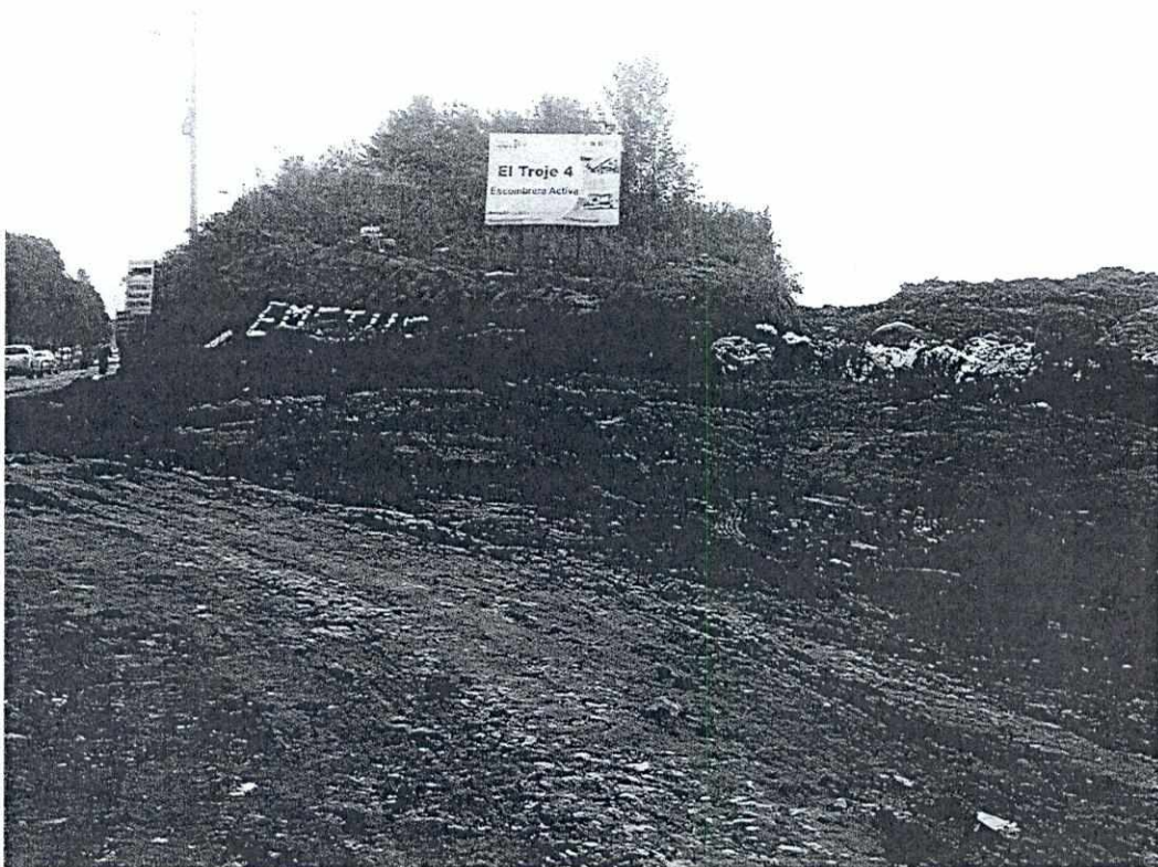
Vía de ingreso/salida de escombrera activa El troje 4 hacia la Av. Simón Bolívar. 20/05/17
