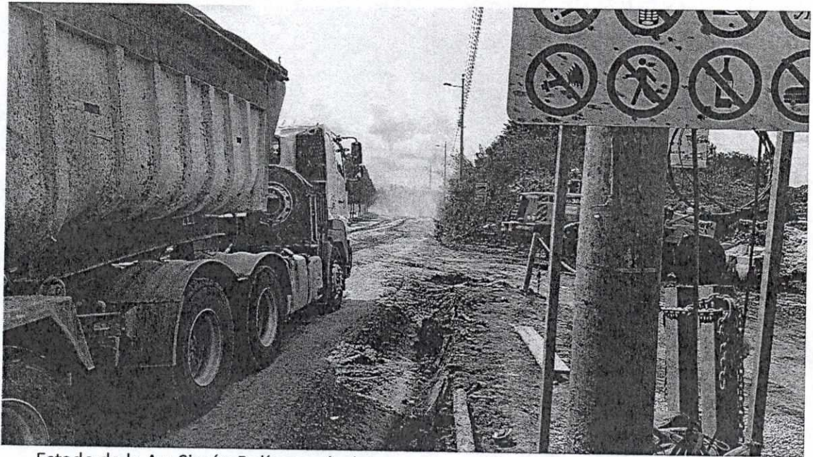
Estado de la Av. Simón Bolívar y vía de entrada y salida a la escombrera El Troje 4. 21/05/2017
