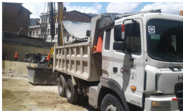
Salida de Emergencia 9
