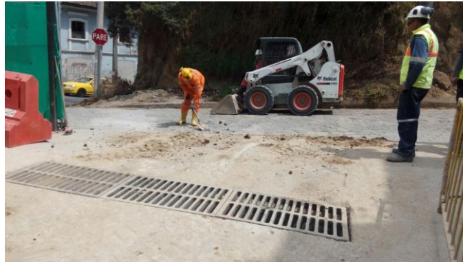
Salida de Emergencia 9
