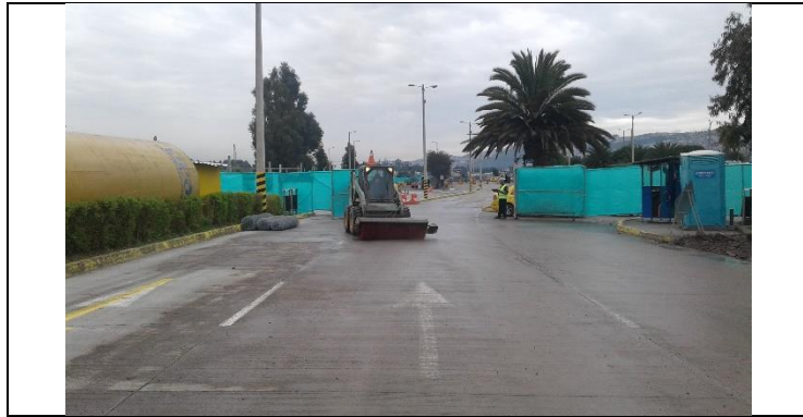
Túnel Acceso a Cocheras
