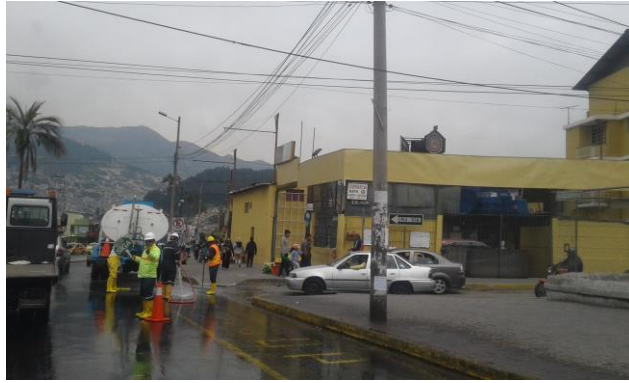
Pozo de Ventilación 5
