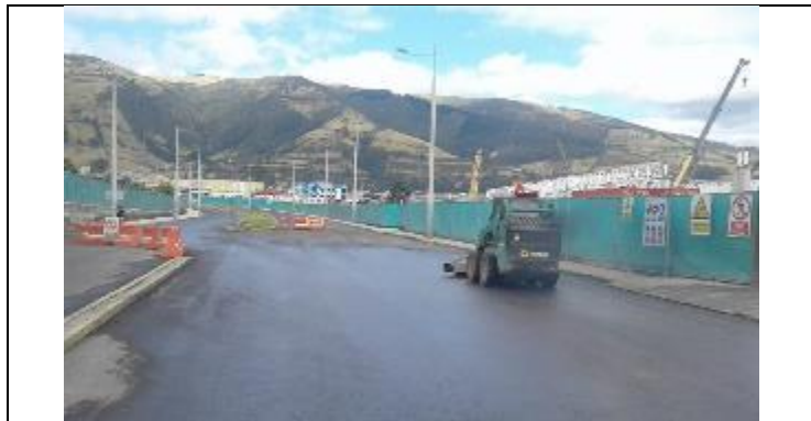
Patio de Talleres y Cocheras
