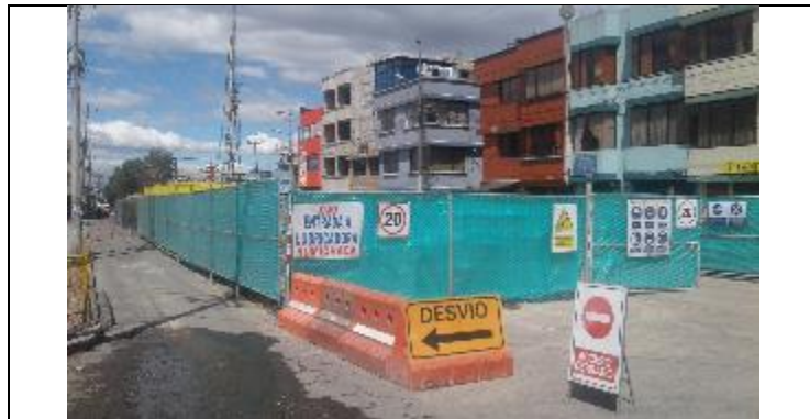
Pilotes y Tratamiento de Terreno en Avenida Rumichaca
