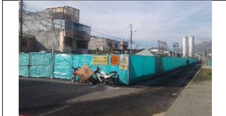
TRT Jet Grouting Salida de Emergencia 3
