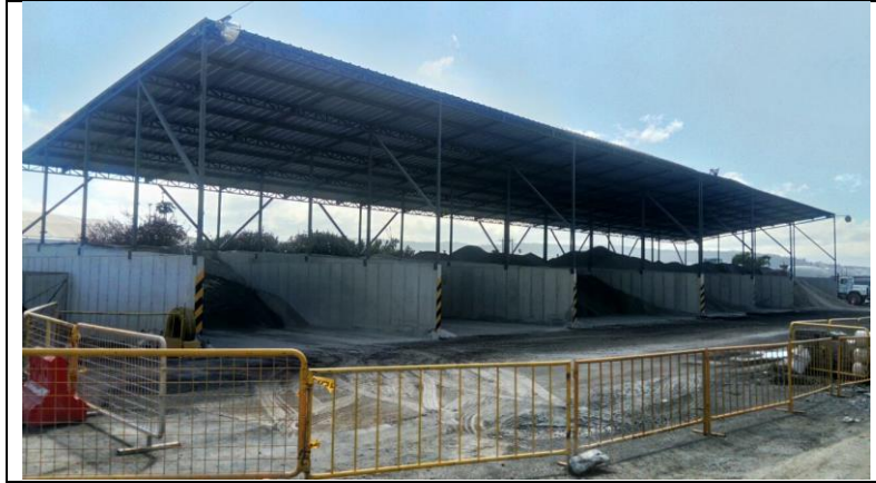
Planta de Hormigón-Fondo de Saco
