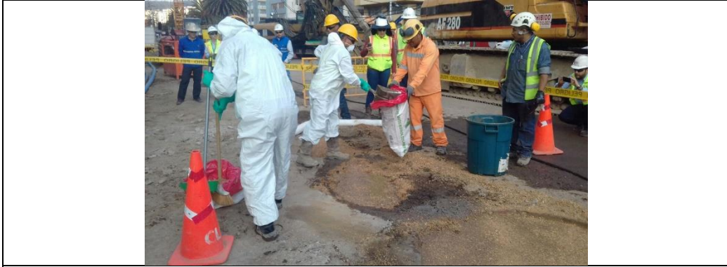
Limpieza y recolección del material contaminado
