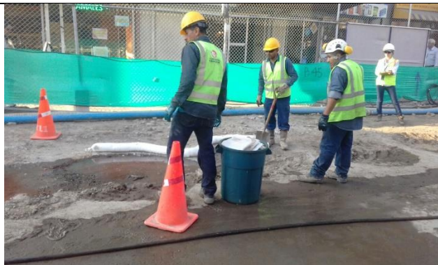
Llega técnico de SSTMA de IFCE y con su personal inicia contención del derrame
