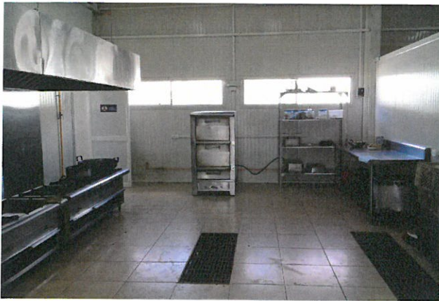
Fecha registro: 09/08/2017 Descripción: CONFORME
