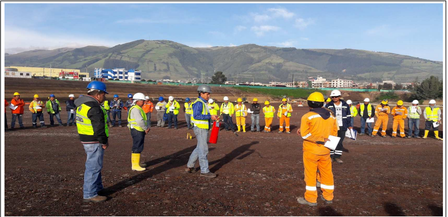
Frente de Obra: Talleres y Cocheras
