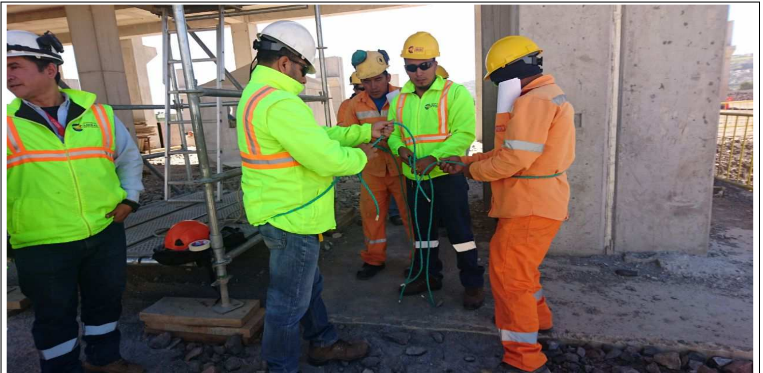
Frente de Obra: Talleres y Cocheras
