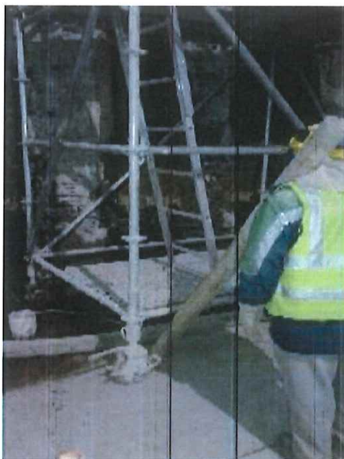
Pie: Simulación, uso de pingo de madera para empujar andamio.
