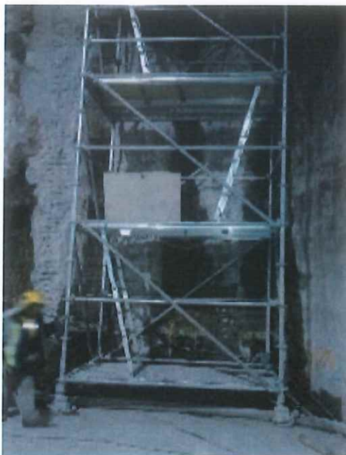
Pie: Cuerpo de andamio móvil a ser desplazado.
