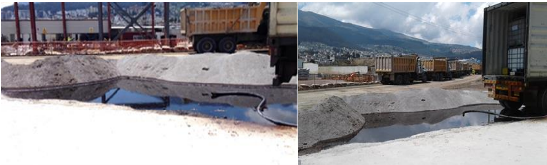
Contención del derrame-Cordón de arena
