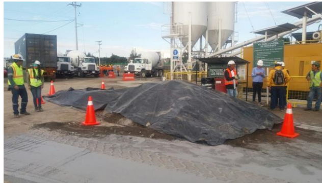
Acopio de arena y suelo contaminado con aditivo
