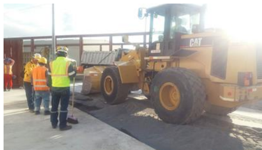
Retiro del suelo contaminado con la cargadora frontal
