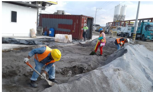
Colocación de material absorbente(arena) sobre el área afectada
