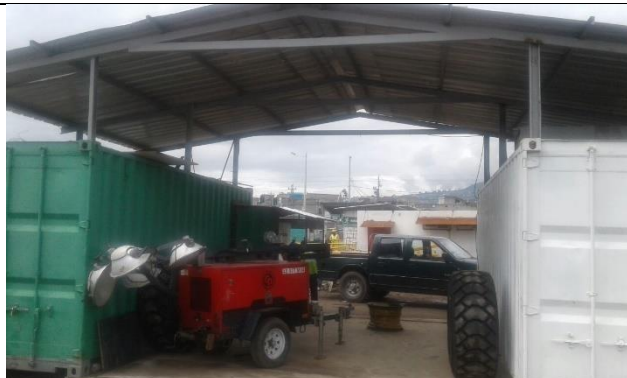
Patio de Talleres y Cocheras
