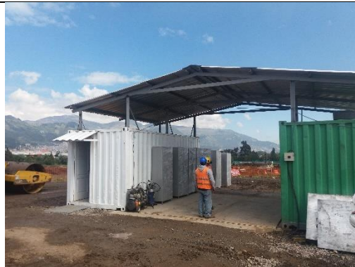
Patio de Talleres y Cocheras
