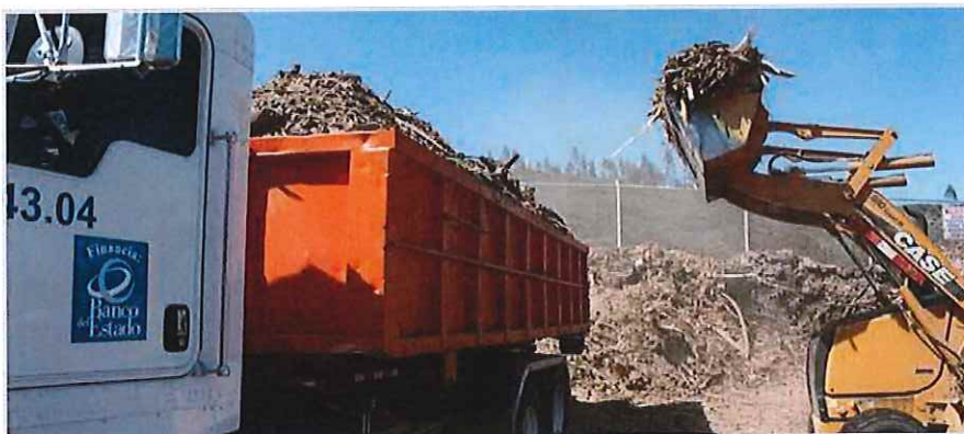
Foto 6-4 Ejemplo de Transporte de material excedente o escombros
