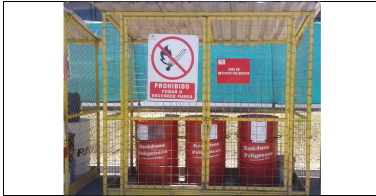
Caseta de acopio temporal de residuos peligrosos
