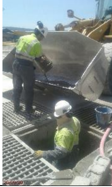
Limpeza de decantador
