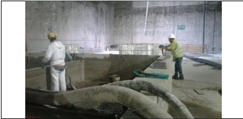
Limpieza de decantador
