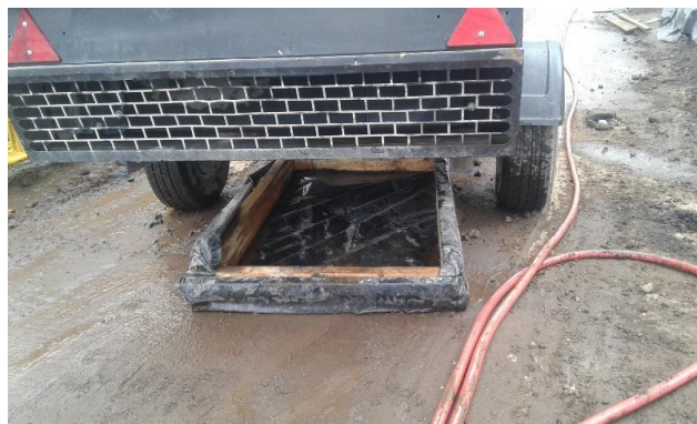
Cubeto en generador
