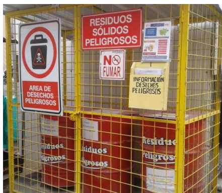
Caseta de acopio temporal de residuos peligrosos
