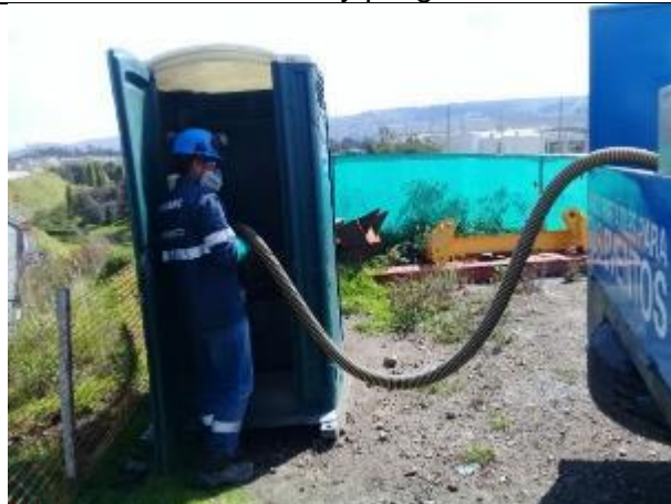
Limpieza de baños químicos por gestor con licencia ambiental
