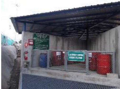
Área de almacenamiento de residuos reciclables y peligrosos
