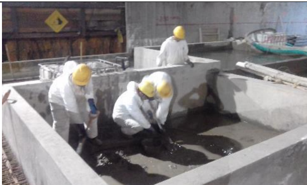
Limpieza de decantador
