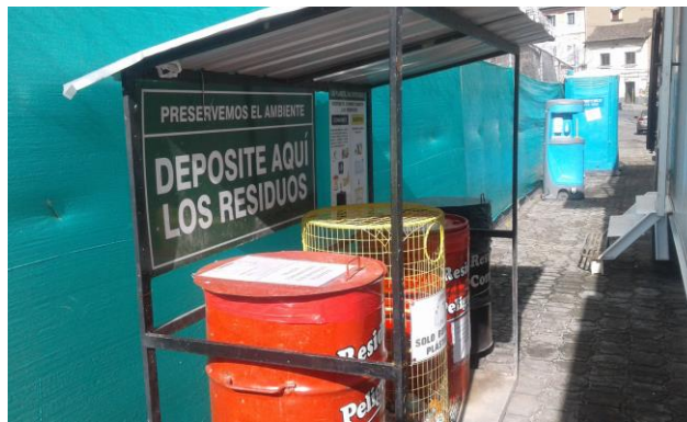
Caseta de acopio temporal de residuos peligrosos
