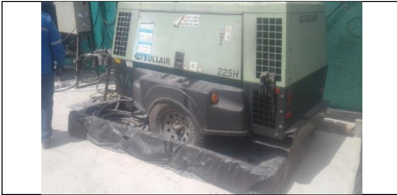
Cubeto de equipos
