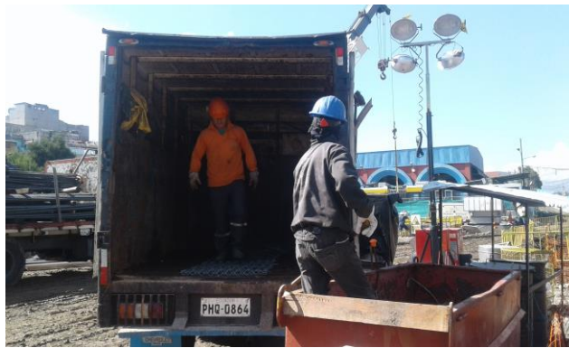
Entrega de restos metálicos al gestor
