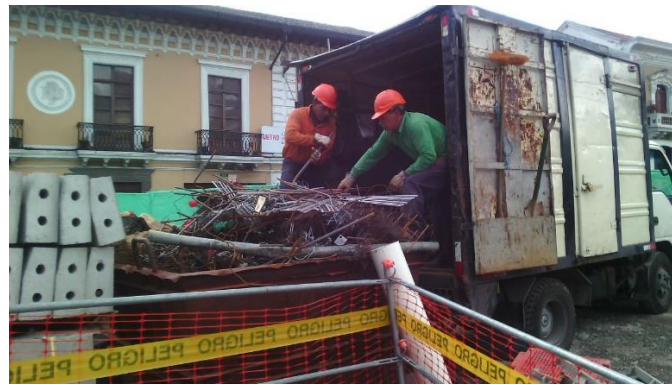
Entrega de restos metálicos al gestor
