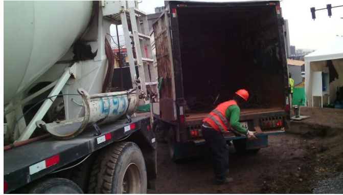
Entrega de restos metálicos al gestor
