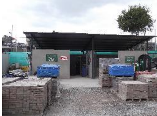
Área de almacenamiento temporal de residuos reciclables y peligrosos
