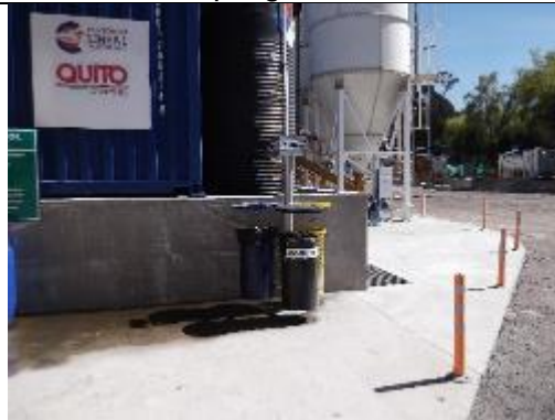
Separación de residuos
