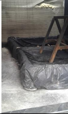
Cubeto de equipos
