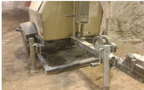
Cubeto en torre de iluminación
