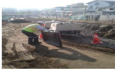
Colocación de cubeto en torre de iluminación
