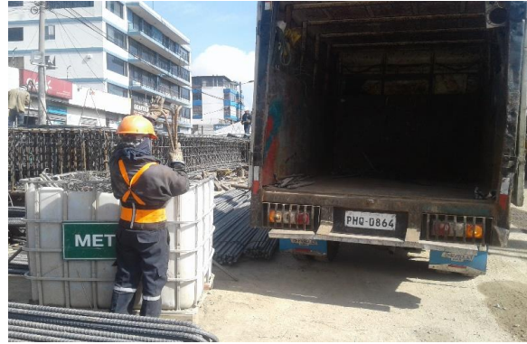
Entrega de restos metálicos al gestor
