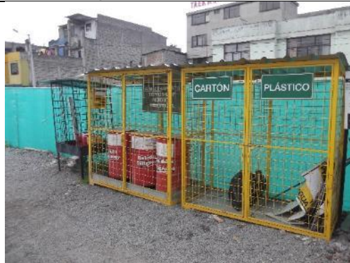
Áreas de almacenamiento temporal de residuos peligrosos y reciclables
