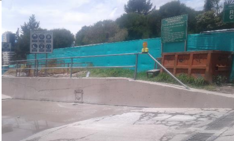
Tanque de almacenamiento de desechos comunes
