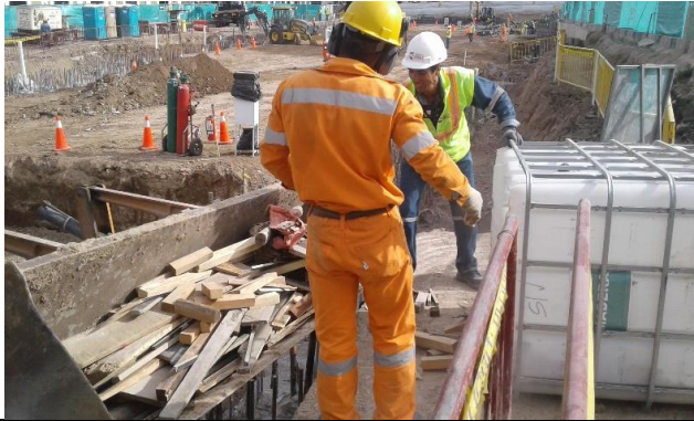
Evacuación de restos de madera
