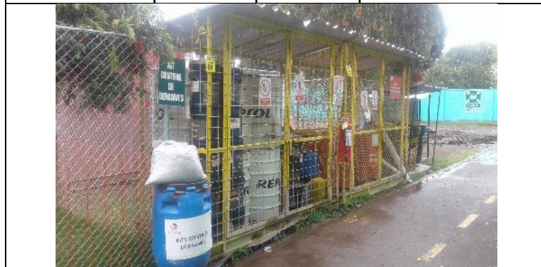
Caseta de grasas y peligrosos-kit de derrames
