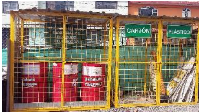
Áreas de almacenamiento temporal de residuos peligrosos y reciclables
