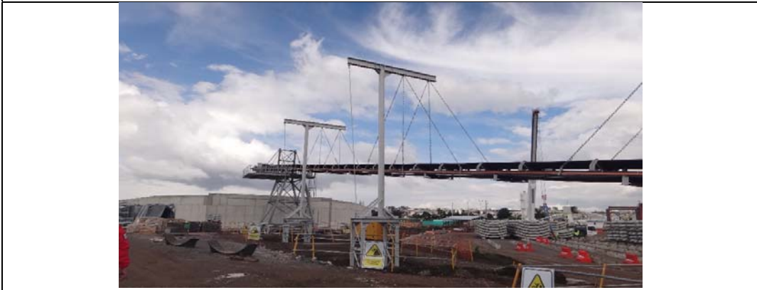
Foto. Sistema de Evacuación de Material Excedente de Operación de TBM
