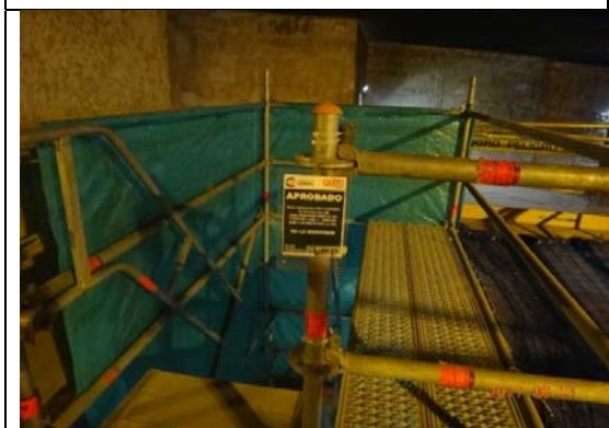
Foto. Andamios aprobados para acceso a contra bóveda
