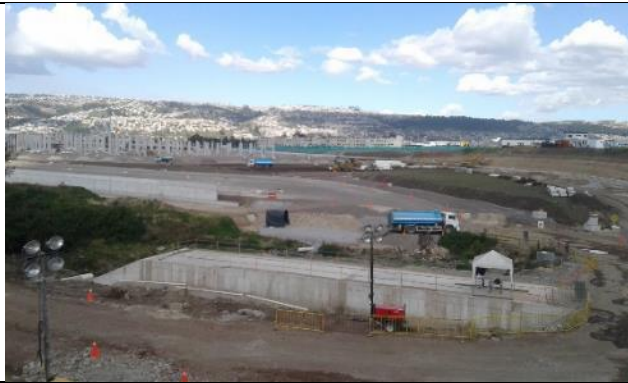
Patio de Talleres y Cocheras
