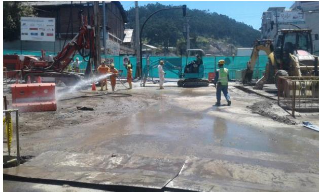
Tratamiento de Terreno en Rodrigo de Chávez
