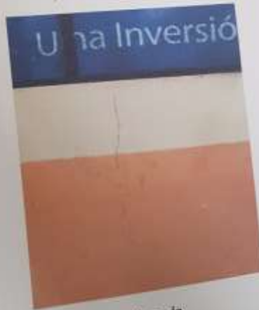
pared fisurada
