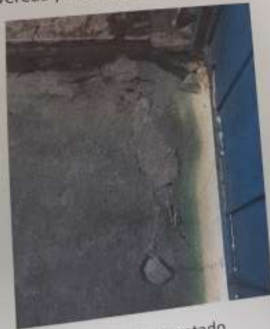
Piso de la entrada levantado
