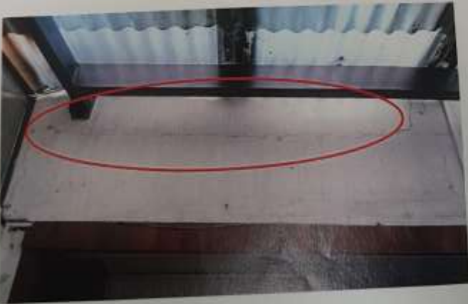
PARED SUPERIOR DE PATIO LATERAL
