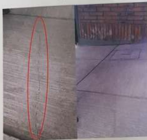
PISO DE GARAJE
