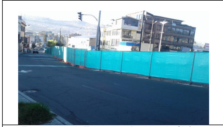
Tratamiento de Terreno en Rodrigo de Chávez
