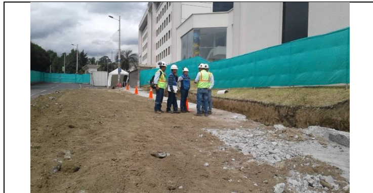
Tratamiento de Terreno Universidad Salesiana Av. Rumichaca
