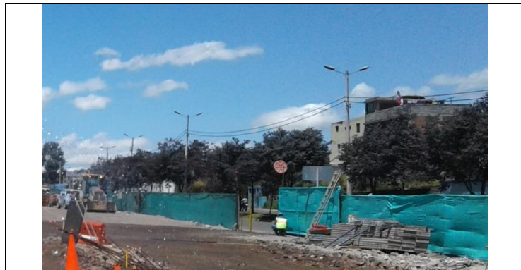
Túnel de Acceso de Cocheras – Fase Av. Mariscal Sucre
