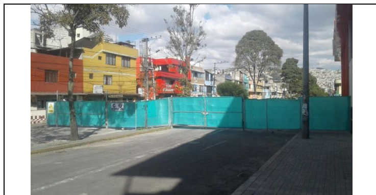
Pozo de Ventilación 2
