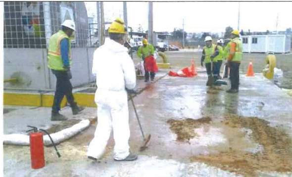
Retiro del tanquero para coninuar la limpieza y recolección de desechos
