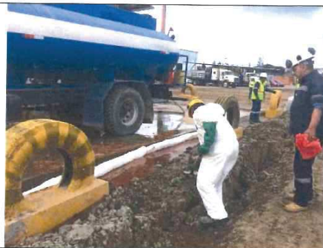
Construcción de zanjas y colocación de salchichas para evitar la propagación del combustible
