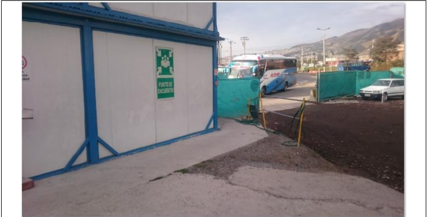
Frente de Obra: VARIANTE QUITUMBE
