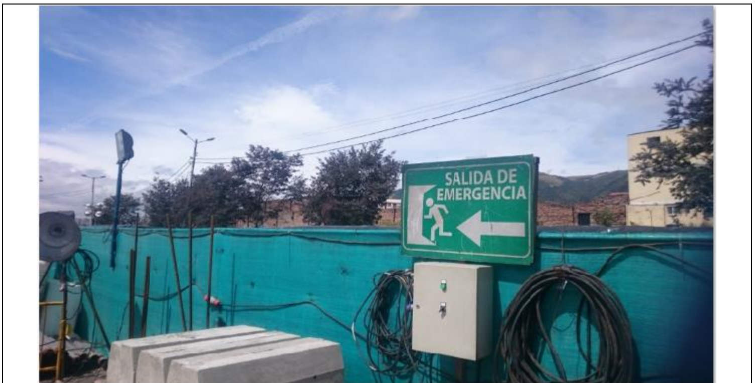
Frente de Obra: VARIANTE QUITUMBE
