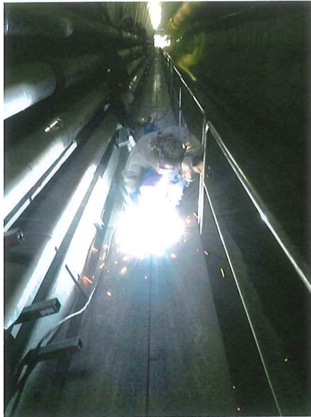
Imagen 5. Aseguramiento y fijación de las pasarelas, refuerzo contra el vuelco y estabilidad de la misma.
