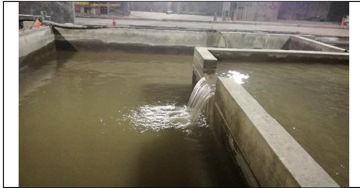
Decantador de aguas de infiltración
