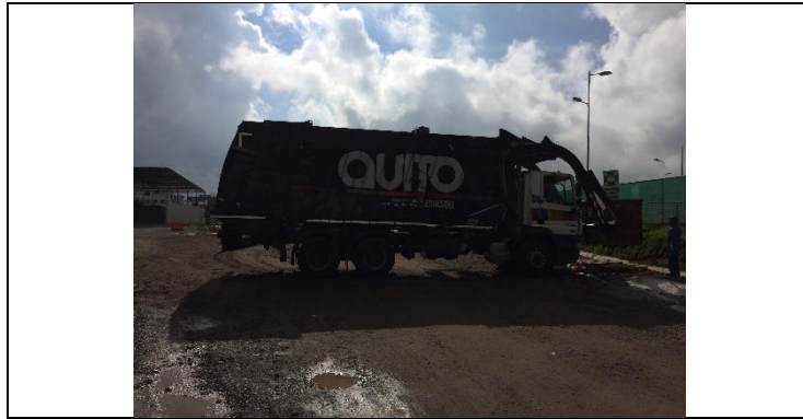
Evacuación de desechos comunes
