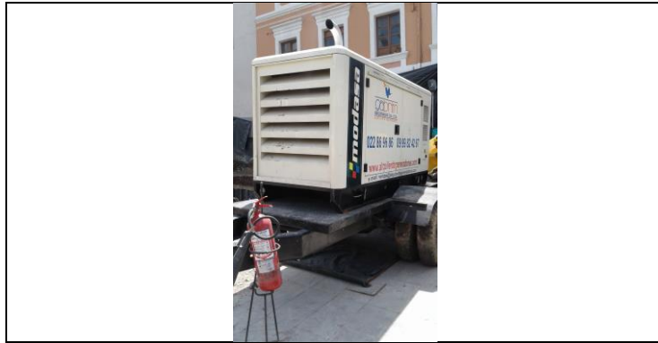
Generador con su respectivo cubeto
