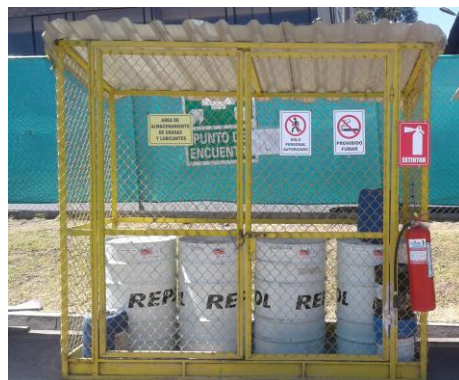
Caseta de acopio temporal de grasas y aceites
