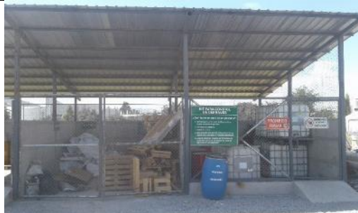
Área de almacenamiento temporal de residuos reciclables
