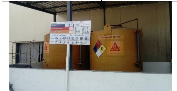
Etiquetas productos químicos
